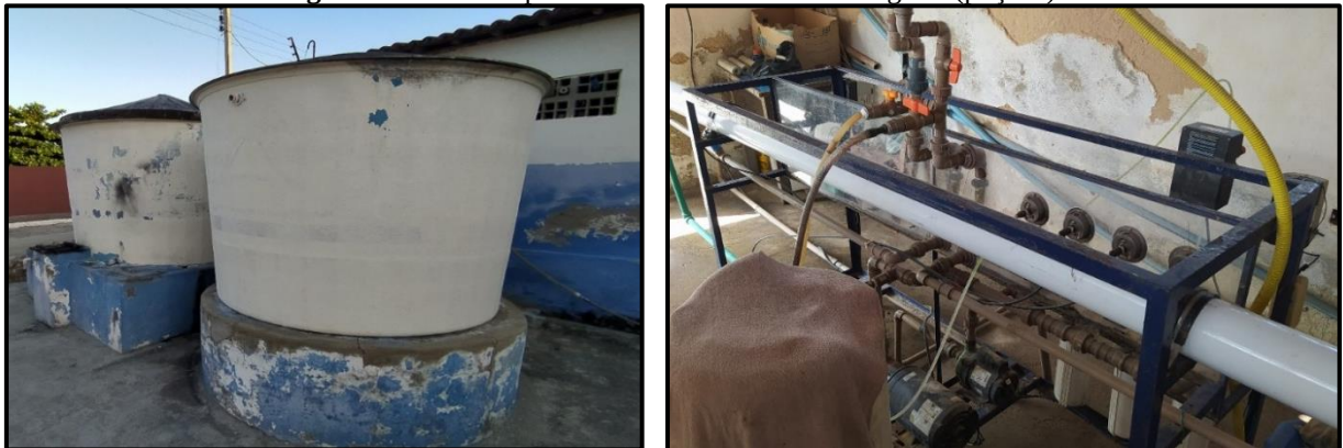
Figura 7 – Chafariz público na comunidade de Bengalas (poço E)
