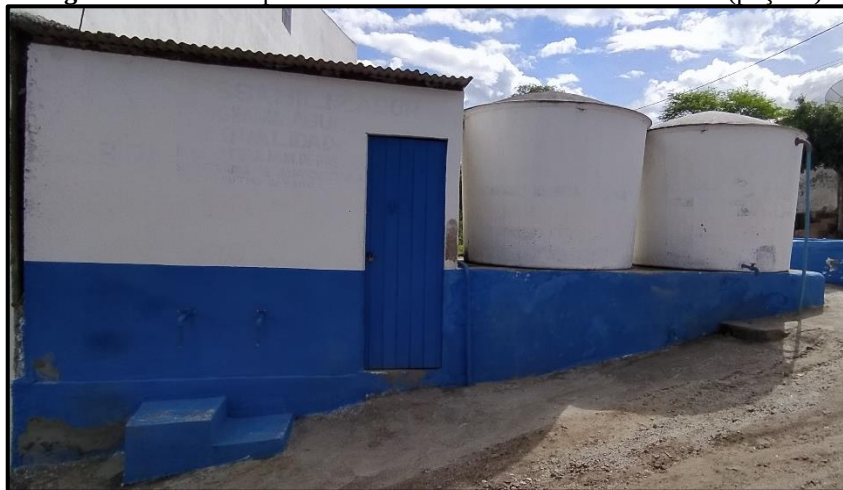
Figura 3 – Chafariz público na comunidade de Cutias de Baixo (poço A)
