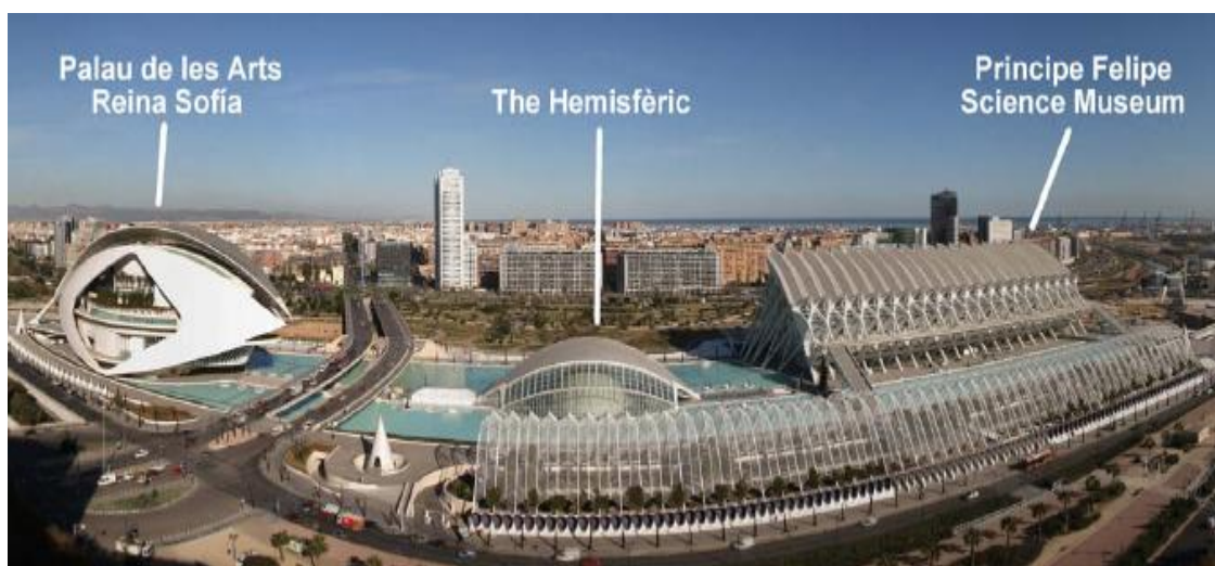
Figura 1.2. Museu Príncipe Felipe na Espanha, refrigerado através de um sistema de absorção de duplo efeito com brometo de lítio-água, usando gás natural como fonte de calor do chiller. (Fonte: E. Torrella et al., 2008).
