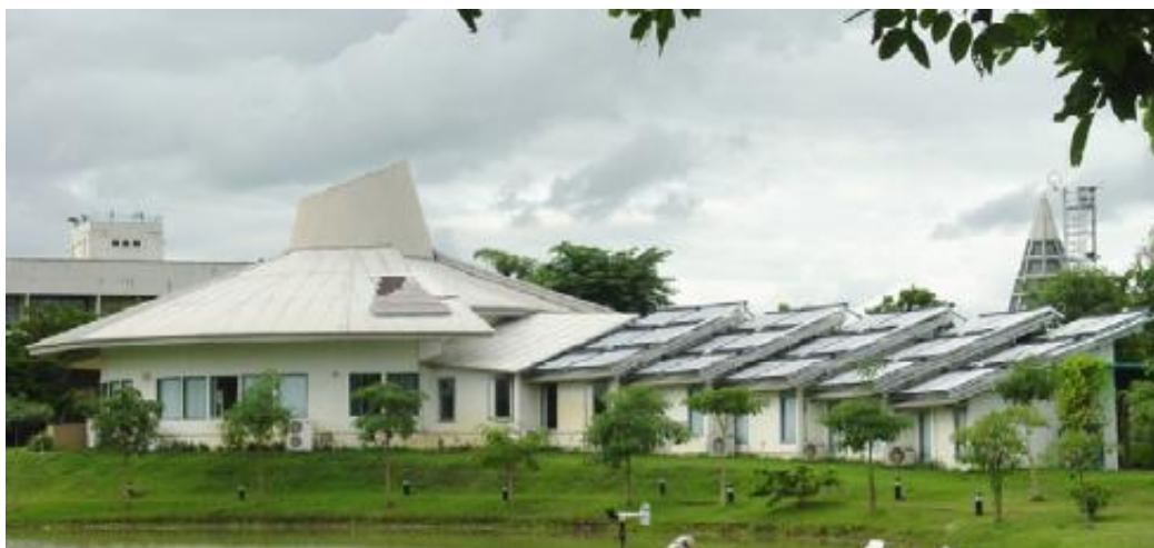
Figura 1.1. Laboratório da Universidade de Nareasuan na Tailândia, refrigerado através de um sistema de absorção com brometo de lítio-água, usando energia solar e gás natural como fonte de calor do chiller. (Fonte: A. Pongtornkulpnitch et al., 2008).
