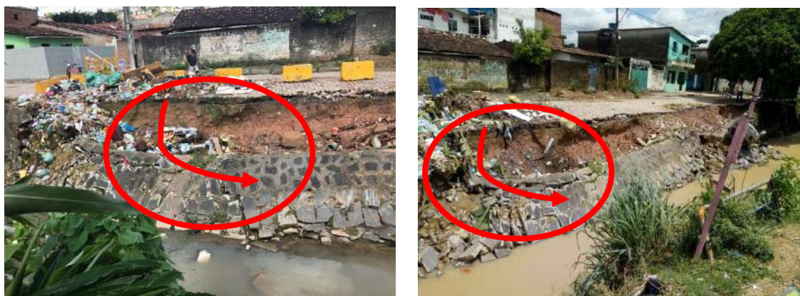
Figura 39 – Deslizamento ocorrido ao pé da encosta nas paredes do canal (abril de 2018).
