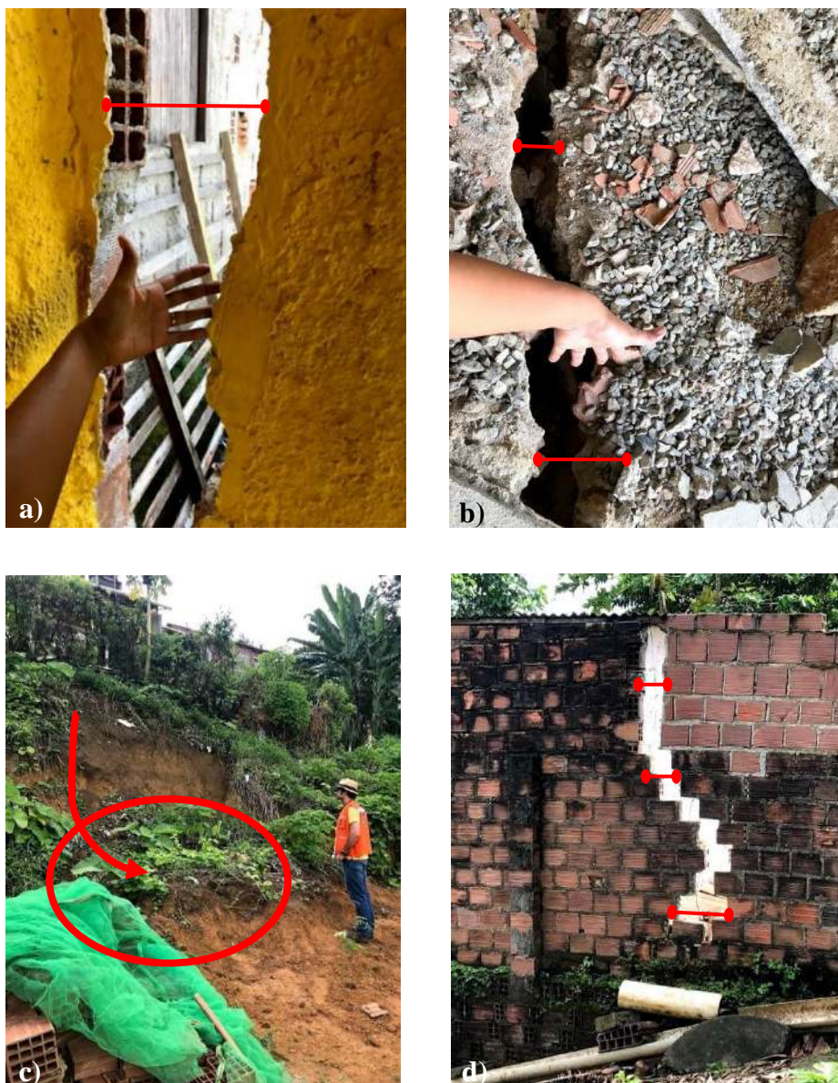
Figura 40 – Consequências dos deslizamentos ocorridos em 24/07/19. a) Parede de casa com trincas; b) Piso de casa que cedeu; c) Ruptura localizada de encosta; d) Muro que se partiu por ruptura no solo.
