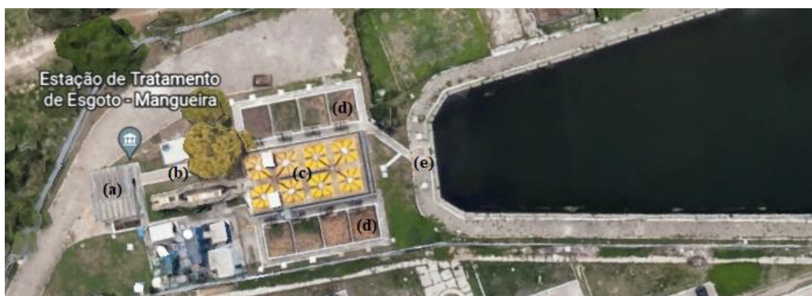
Figura 5 - Unidades de tratamento da ETE Mangueira
