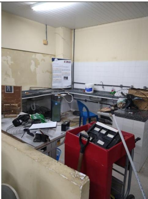
Como relatado, o laboratório além de conviver com má adequação do espaço interno, também sofre com infiltrações, serve de depósito de materiais e recentemente sofreu com infestação de cupins.
