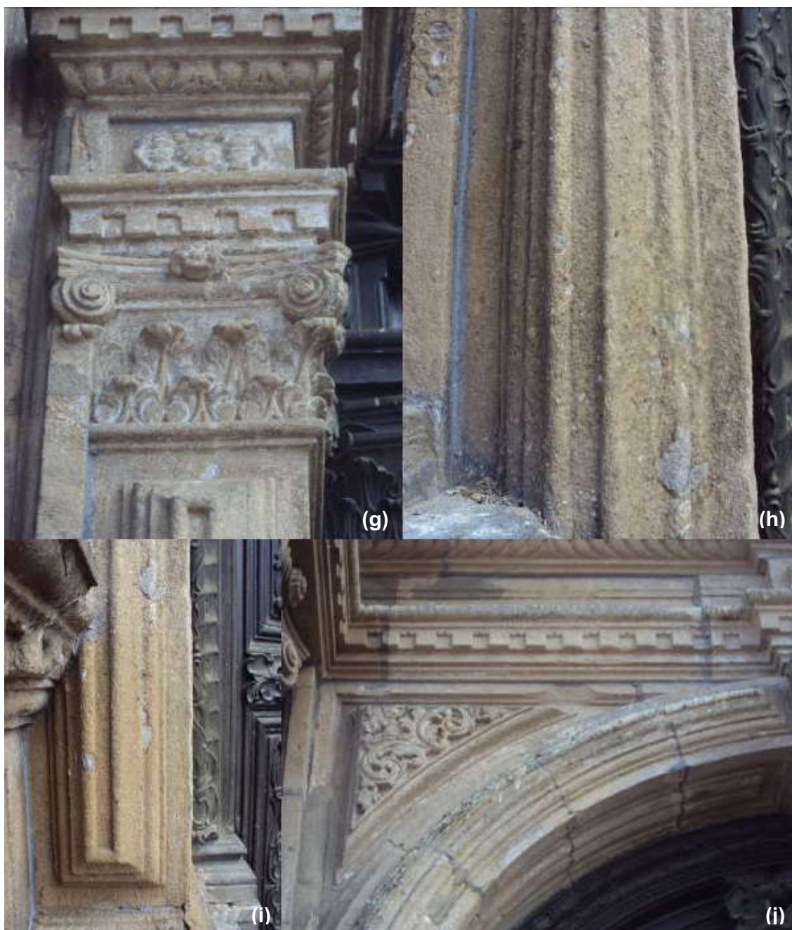
Figura 3.34 – Igreja de São Pedro dos Clérigos/Pórtico central. Patologias identificadas sobre a superfície, conforme o elemento, dos blocos componentes do corpo. Fotos: (g) 7-incrustação; (h) 8-pitting e erosão; (i) 9-coloração e intervenção com material de vedação nas juntas; (j) 10-excremento. Fonte: autor.
