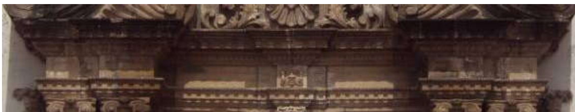
Figura 3.35 - Entablamento do pórtico central da Igreja de São Pedro dos Clérigos e suas partes integrantes: parte inferior – arquitrave, central – friso e superior – cornija, todas ressaltadas nos extremos laterais e parte central. Fonte: autor.
