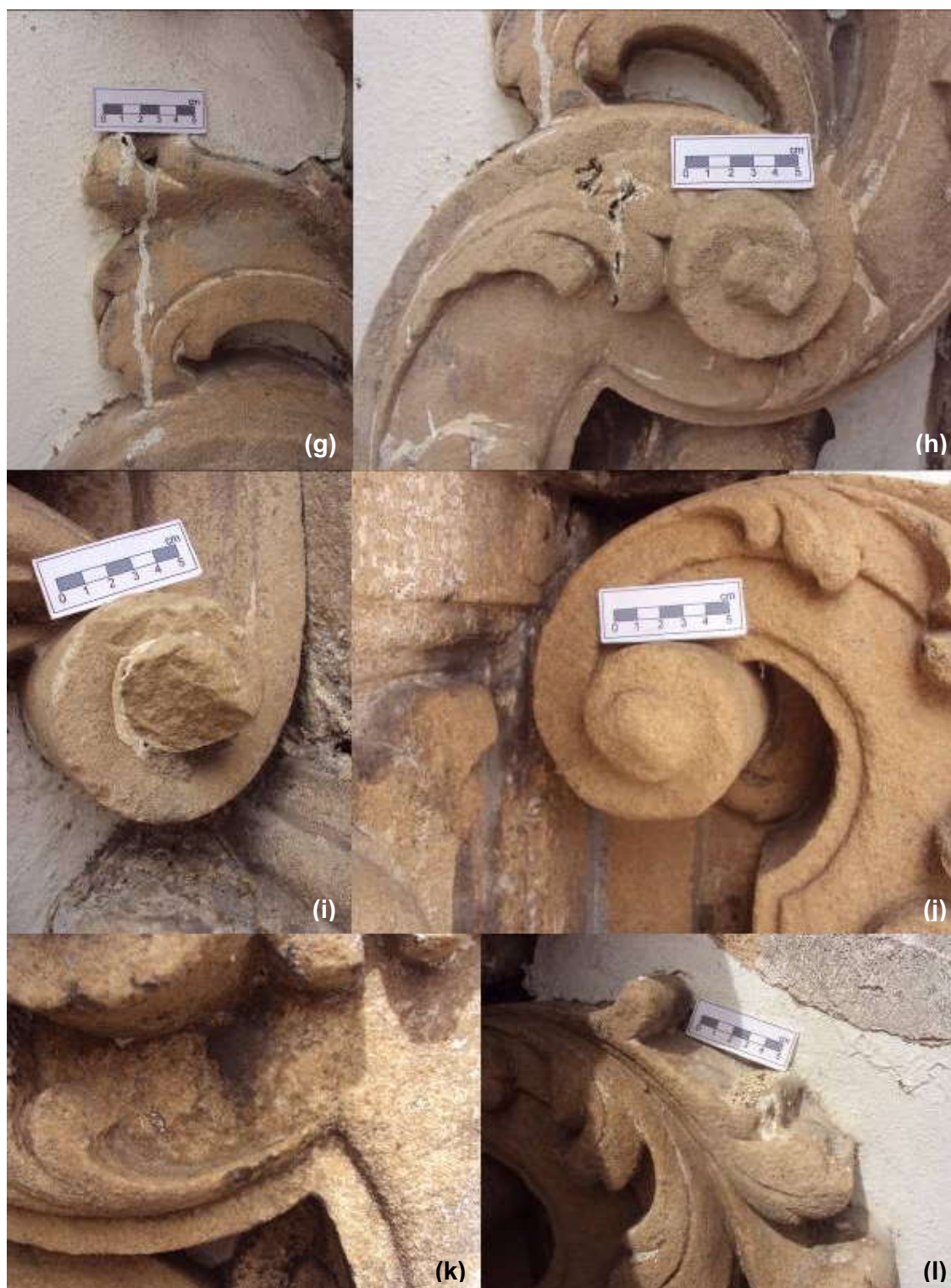
Figura 3.31 – Igreja de São Pedro dos Clérigos/Pórtico central. Patologias identificadas sobre a superfície, conforme o elemento, dos blocos componentes da base. Fotos: (g) 7-depósito superficial – tinta; (h) 8-excremento; (i) 9-lacunas/perdas/partes faltantes; (j) 10-coloração; (k) 11-fungo e (l) 12-sujidade e depósito superficial. Fonte: autor.
