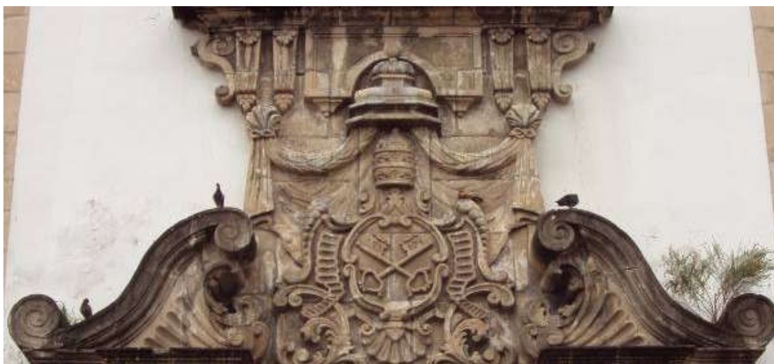
Figura 3.38 - Coroamento do pórtico central da Igreja de São Pedro dos Clérigos e suas partes integrantes: frontão interrompido com as volutas nos extremos laterais e, no plano recuado, medalhão com sua ornamentação; nota-se a presença constante de pombos sobre os elementos desta parte da composição. Fonte: autor
