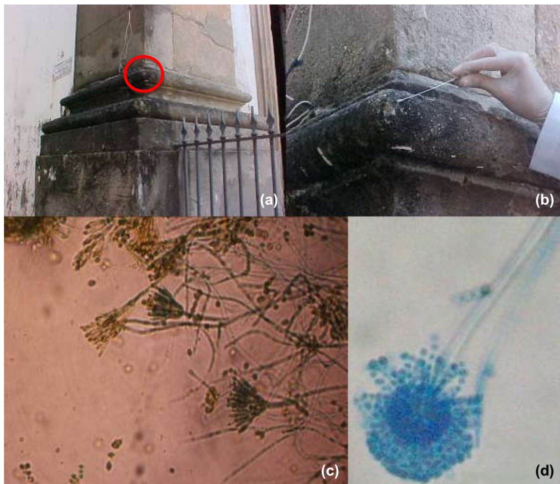
Figura 3.65 - Igreja de São Pedro dos Clérigos. Fotos (a) e (b) local da coleta do material microbiológico – cunhal direito, base – altura da coleta de 224 cm; (c) e (d) fungos identificados na amostra 10 – (c) Penicillium islandicum ; (d) Aspergillus sydowii . Fotos (c) e (d) tiradas a partir do microscópio. Fonte: autor (a) e (b); (c) e (d) Nadyr Pedi.
