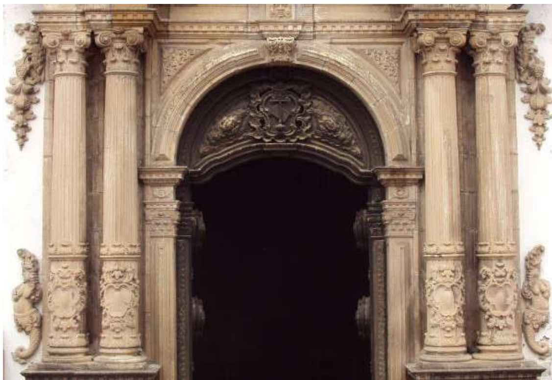
Figura 3.32 - Corpo do pórtico central da Igreja de São Pedro dos Clérigos e suas partes integrantes: apliques laterais, colunas e cercadura com pé direito – pilastra e capitel – impostas, arco pleno – saiméis, contrafechos e fecho, encimados nos extremos laterais pelos rins. Fonte: autor.
