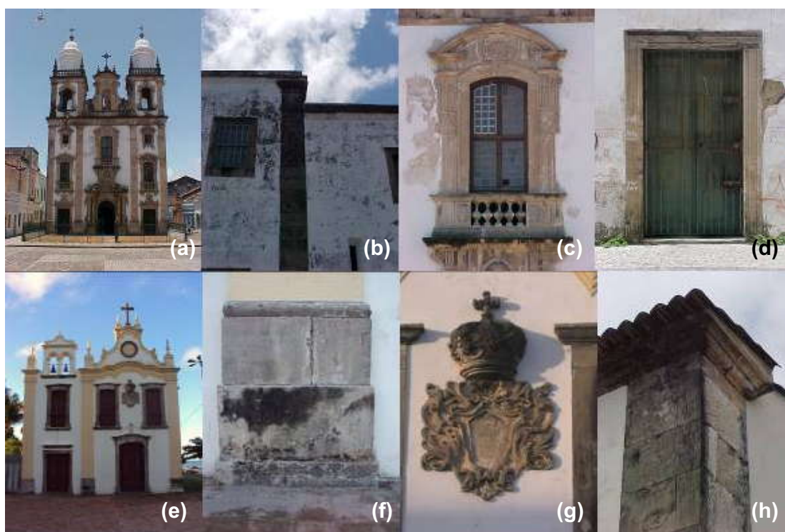
Figura 3.6 - Identificação e ocorrência do arenito nos dois monumentos objetos de estudo – litotipo empregado nos blocos dos elementos estruturais e ornamentais dos objetos vinculados as superfícies construídas (fachadas). Fotos de (a) a (d) ISPC e de (e) até (h) INSP; foto (a) frontispício com seus bens integrados (cor bege); (b) fachada lateral direita – cunhal e cercadura da janela; (c) janela central (côro) acima do pórtico central – frontispício; (d) portada – fachada lateral direita; (e) frontispício com seus bens integrados que compõe os vãos e bases dos cunhais e pilastra; (f) base pilastra - frontispício; (g) brasão com seus ornatos em relevo - frontispício; (h) cunhal e cornija do beiral – fachada lateral esquerda. Fonte: autor.
