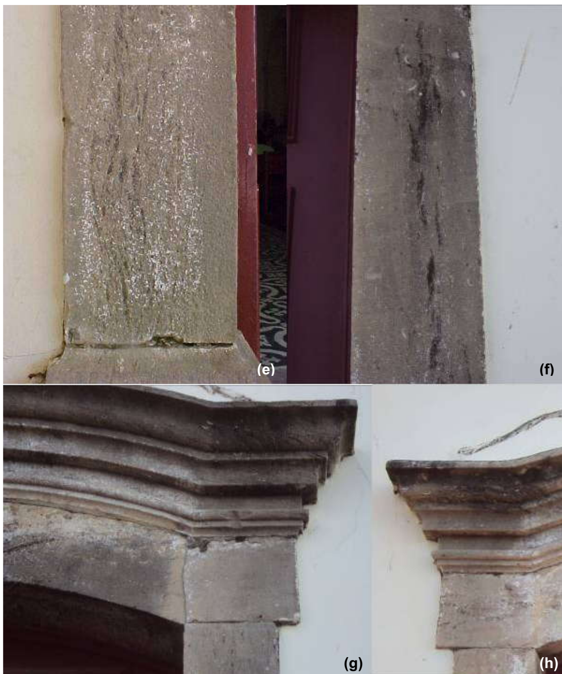
Figura 3.51 – Igreja de Nossa Senhora da Piedade/Portada central. Patologias identificadas sobre a superfície dos blocos que compõe as partes da composição do bem integrado denominado portada central. Foto (e) bloco B2 - 4 - alveolização, incrustação e lacuna/perda/partes faltantes; (f) bloco B5 - 5 - alveolização; (g) bloco B3 - 6 - fratura; (h) bloco B4 - 7 - depósito superficial e incrustação. Fonte: autor.
