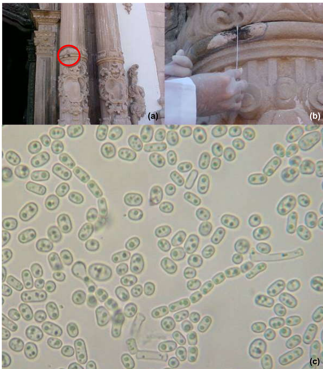
Figura 3.63 – Igreja de São Pedro dos Clérigos. Fotos (a) e (b) local da coleta do material microbiológico – pórtico central, lado esquerdo, coluna direita interna, fuste terço inferior – altura da coleta de 288 cm; (c) fungo identificado na amostra 07 – fungo Geotrichum candidum . Foto (c) tirada a partir do microscópio. Fonte: autor (a) e (b); (c) Nadyr Pedi.
