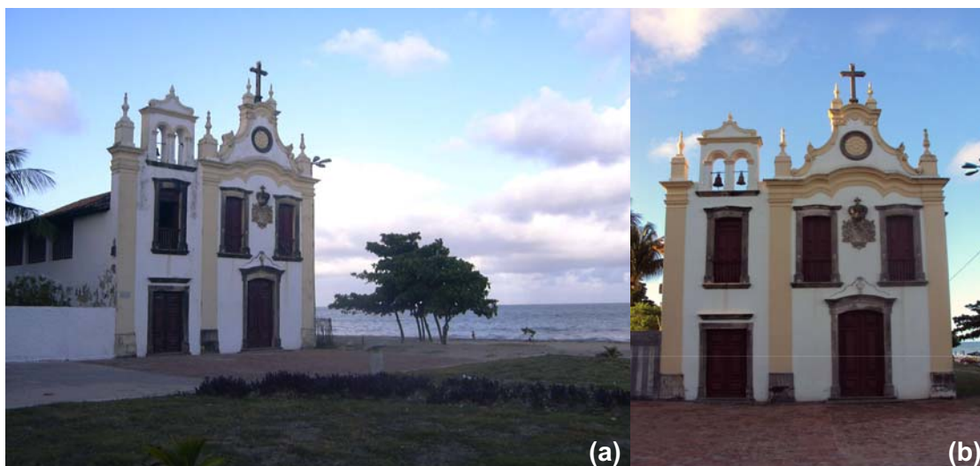
Figura 1.15 - Igreja de Nossa Senhora da Piedade; (a) entorno a leste, sem barreiras físicas – naturais ou artificiais; (b) frontispício e seus bens integrados. Fonte: autor
