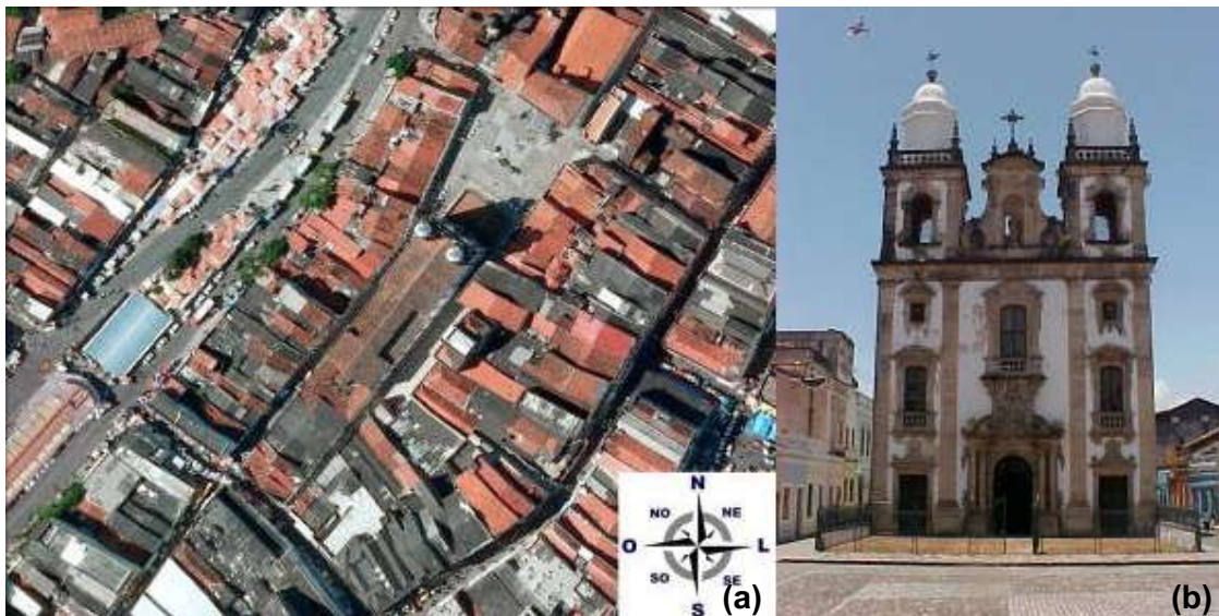
Figura 3.24 - (a) implantação e orientação do monumento; (b) frontispício voltado para o quadrante Nordeste (NE). Fonte: (a) Google Earth; (b) autor.
