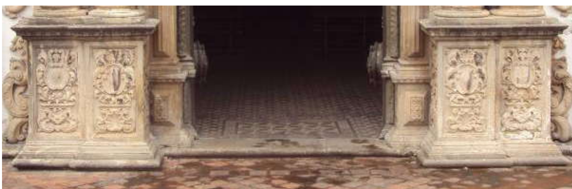
Figura 3.29 – Base do pórtico central da Igreja de São Pedro dos Clérigos e suas partes integrantes: pedestais laterais sob as colunas e pedestais menores, recuados, que compõe a cercadura. Fonte: autor.
