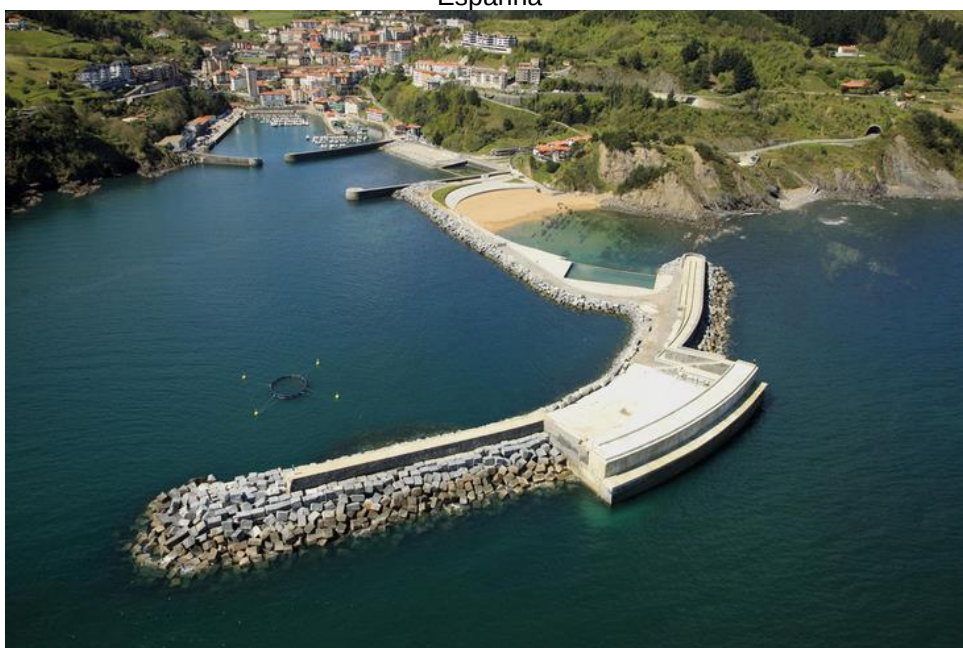
Figura 9 - Usina de ondas do tipo CAO, em operação no quebra-mar do Porto da baía de Mutriku, Espanha
