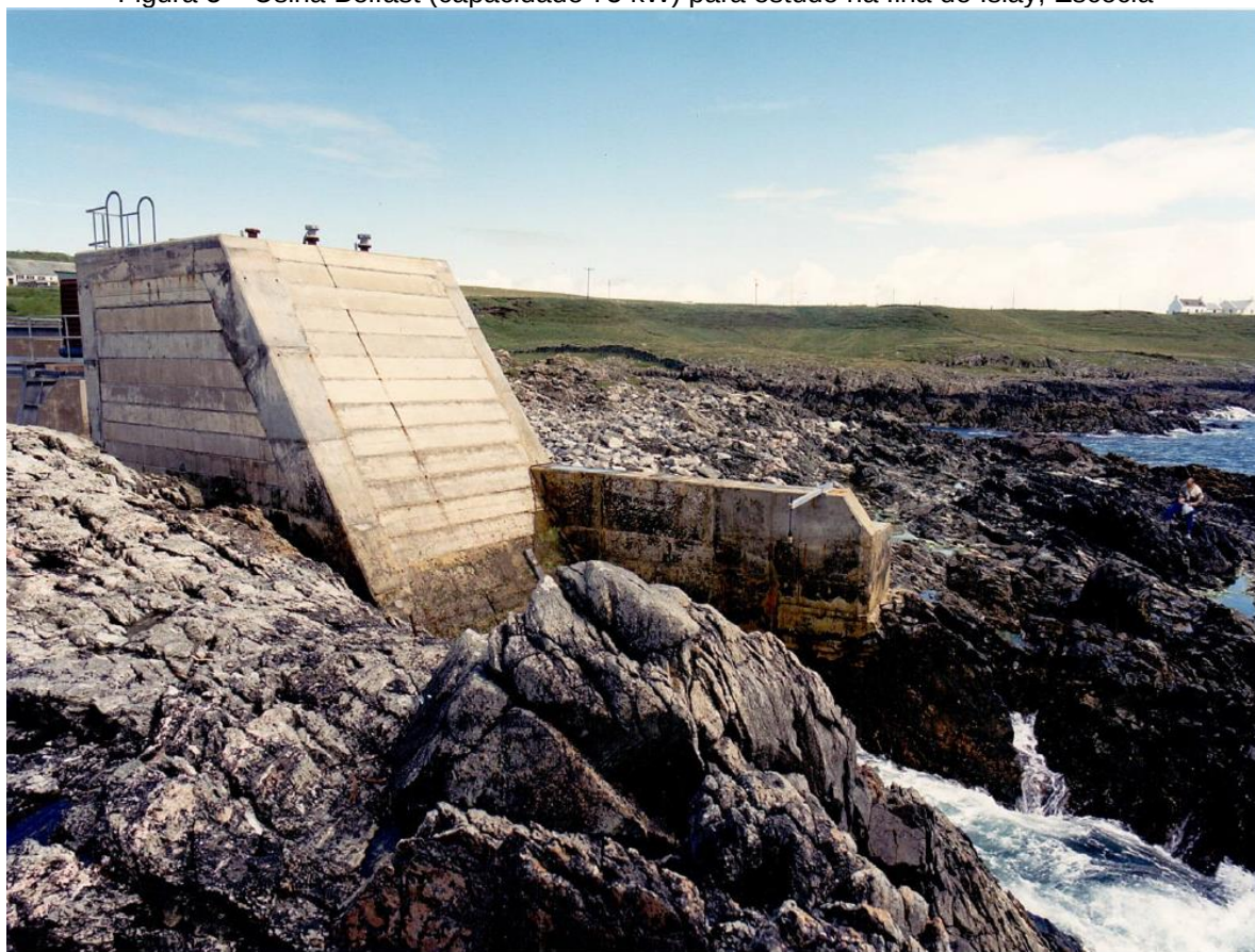
Figura 5 – Usina Belfast (capacidade 75 kW) para estudo na Ilha de Islay, Escócia
