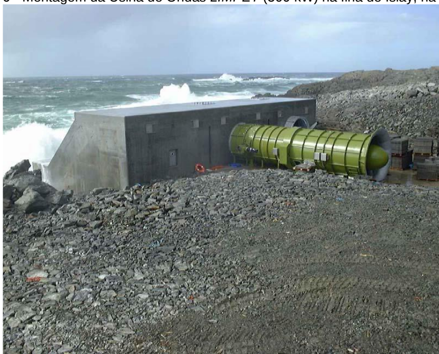
Figura 6 - Montagem da Usina de Ondas LIMPET (500 kW) na Ilha de Islay, na Escócia
