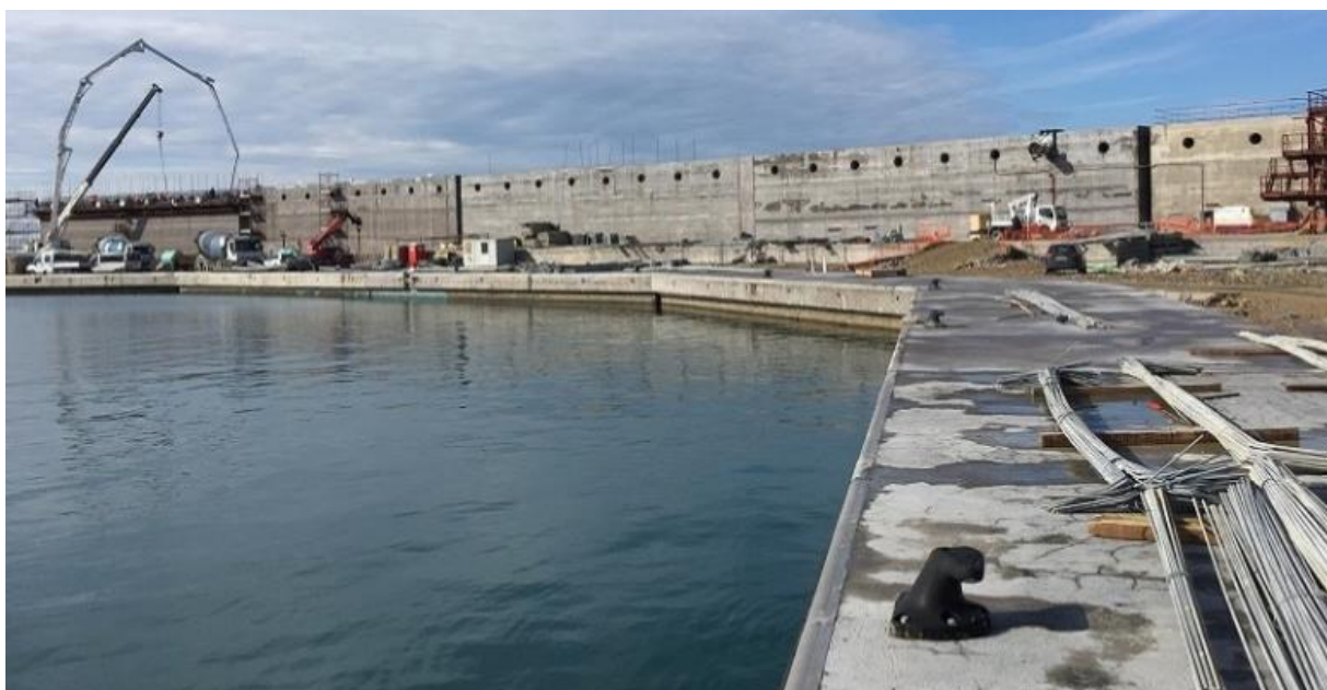
Figura 10 - Usina de CAO REWEC3 sendo construída no porto de Civitavecchia, na Itália
