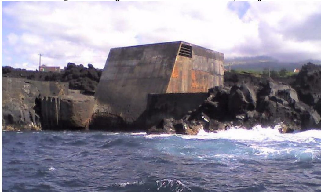
Figura 23 - Fotografia da CAO instalada em Pico, Portugal
