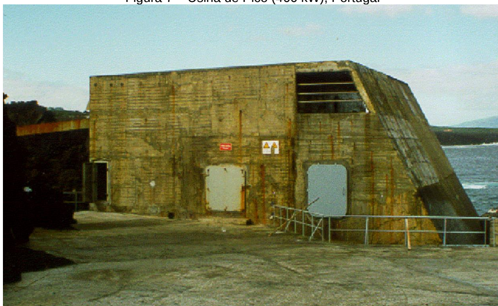
Figura 7 – Usina de Pico (400 kW), Portugal
