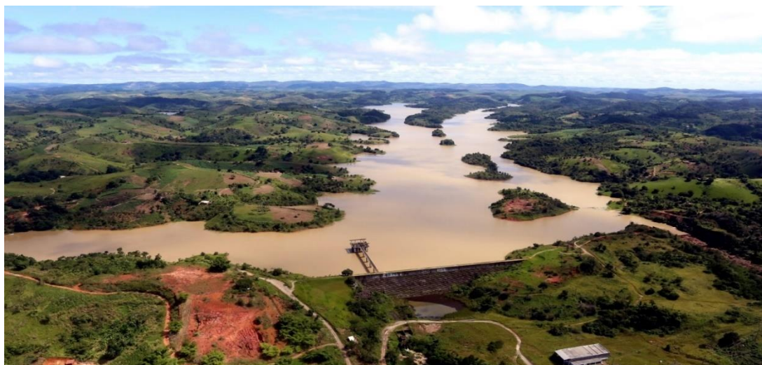
Figura 3. Vista aérea da Barragem de Pirapama, Pernambuco.
