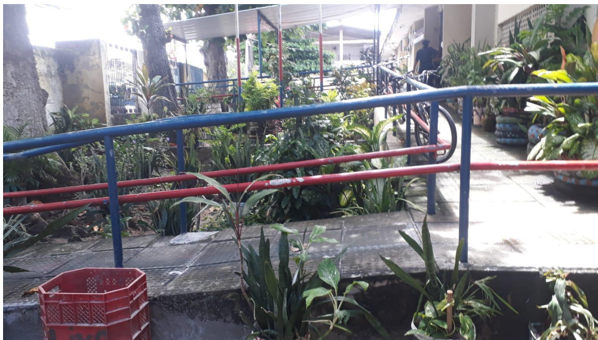
Figura 20 - Rampas externas da E2 e área de jardim
