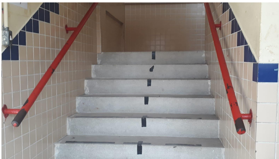
Figura 27 - Corrimãos da escada E2
