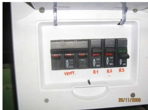
Figura 3.3. Quadro elétrico de comando
