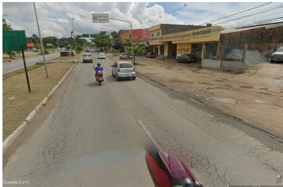
Figura 31 - Trinca no trecho da PE-015
