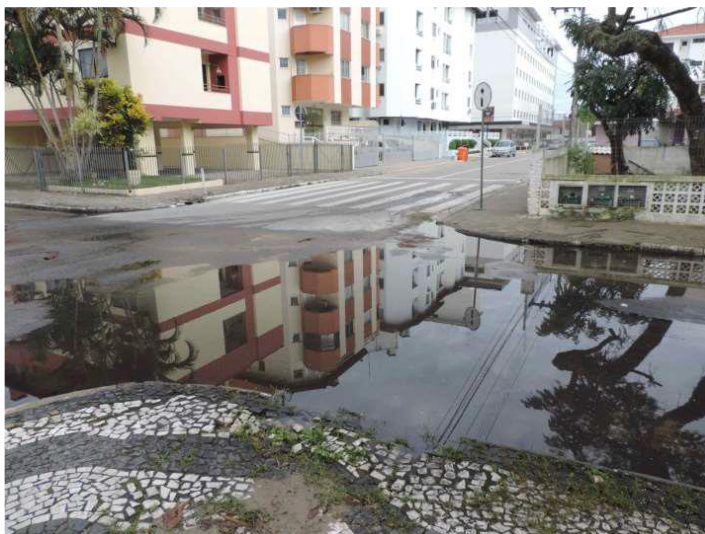
Figura 21 - Alagamento causado por falha no sistema de drenagem
