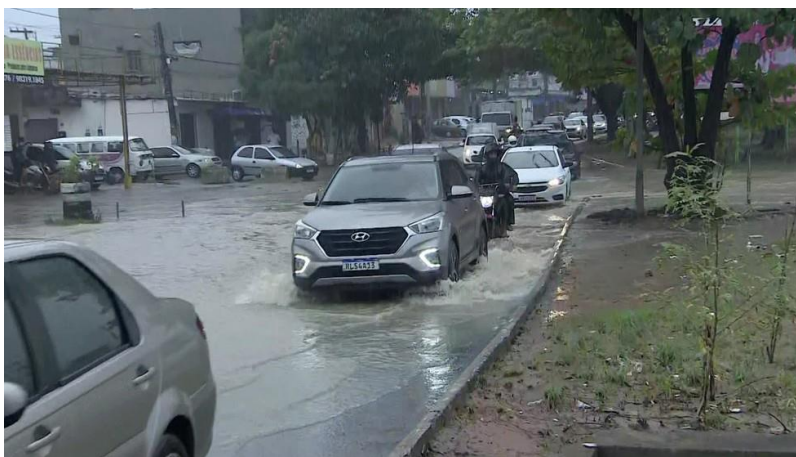
Figura 1 - Alagamento registrado no trecho, em 07 de junho de 2022
