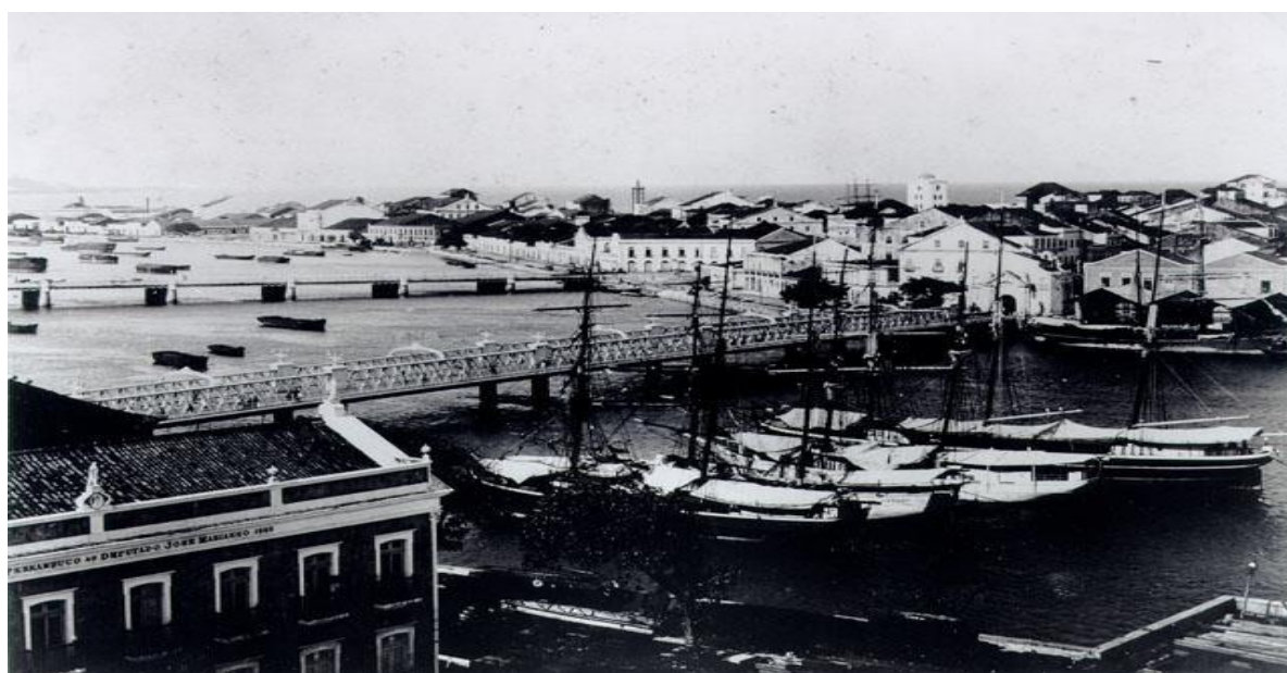
Figura 2 - Vista Geral da Região do Cais 22 de Novembro, Recife PE
