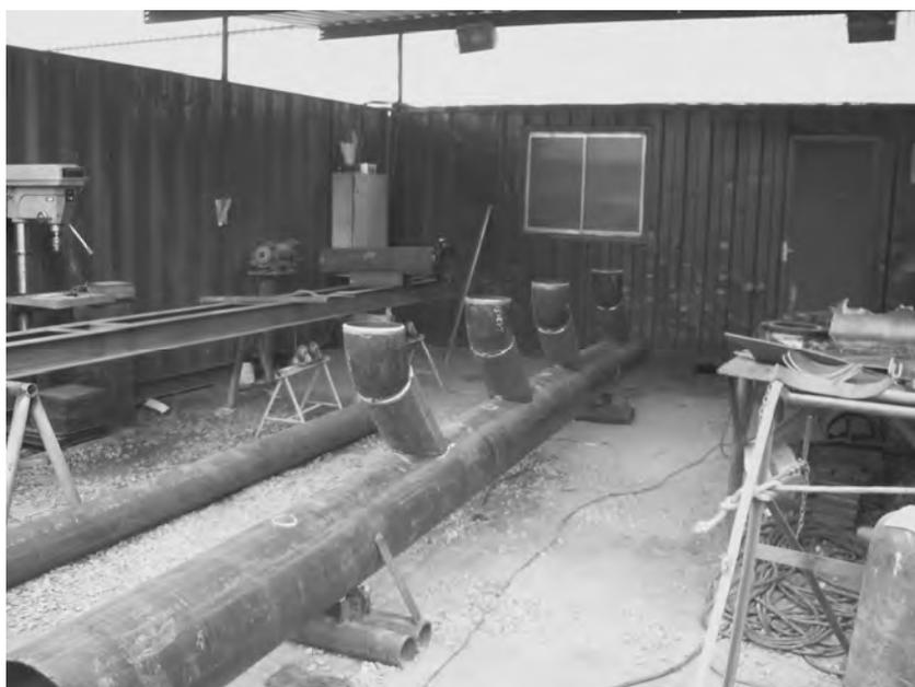
Figura 1.1 – Tubulações preparadas para solda num canteiro de obras (pipe shop), fonte Vórtice Engenharia.
