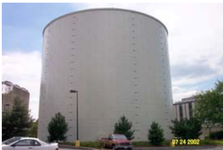
Figura 1. 5 - Tanque de água gelada estratificado termicamente para uso em refrigeração (University of Akron, 2007)
