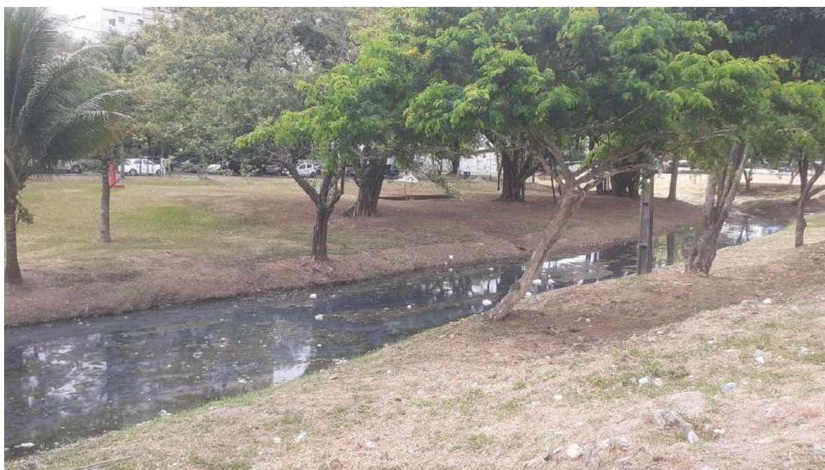
Figura 4.11 - Atual situação do trecho CAC/CTG, vista lateralmente.
