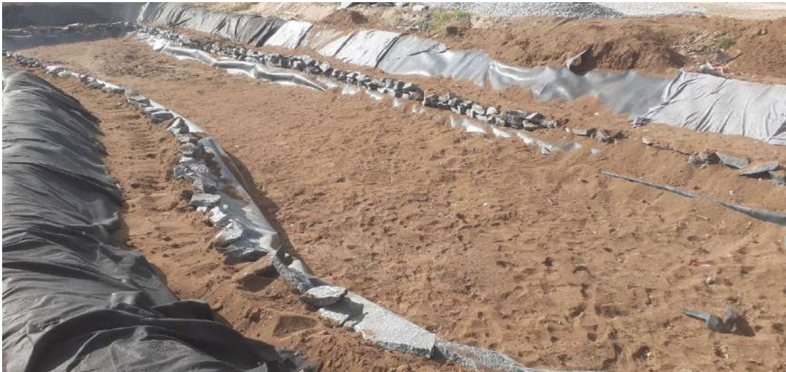
Figura 4.2 - Impermeabilização das valas dos jardins filtrantes do parque Caiara.
