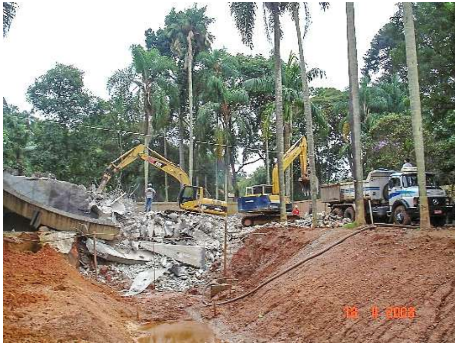
Figura 1.17 - Obras para retirada do calçamento da Alameda Fernando Costa e destamponamento do córrego Pirarungáua.
