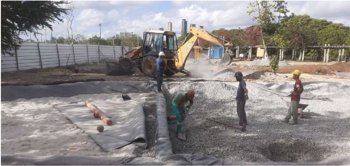
Figura 4.4 - Implantação das camadas de areia e brita dos jardins filtrantes do parque Caiara.
