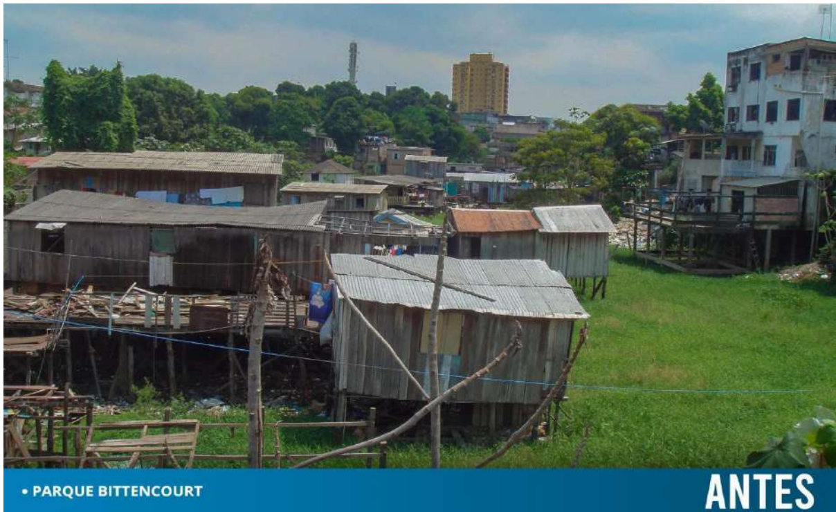
Figura 1.19 - Igarapé Bittencourt, antes da intervenção.
