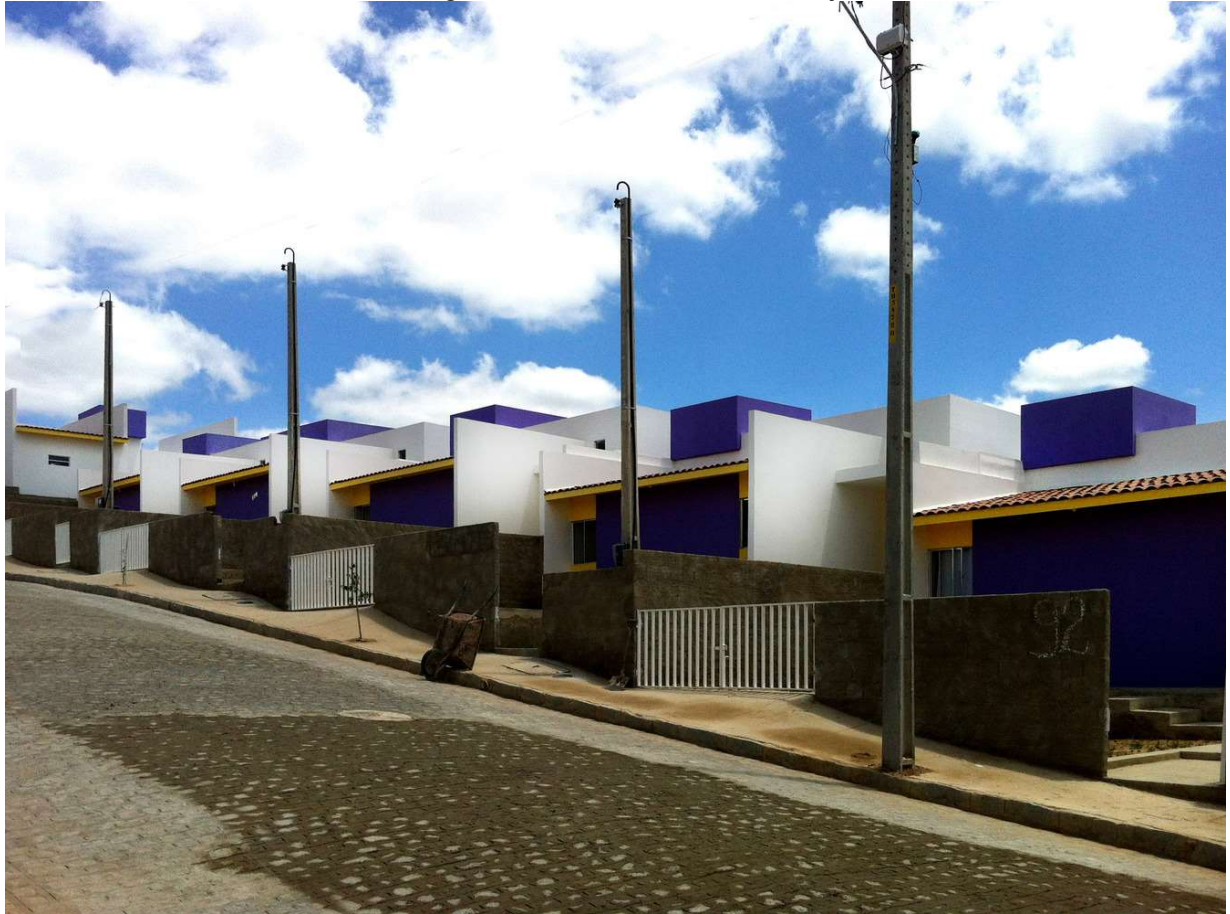
Figura 48: Vista de residências no conjunto.
