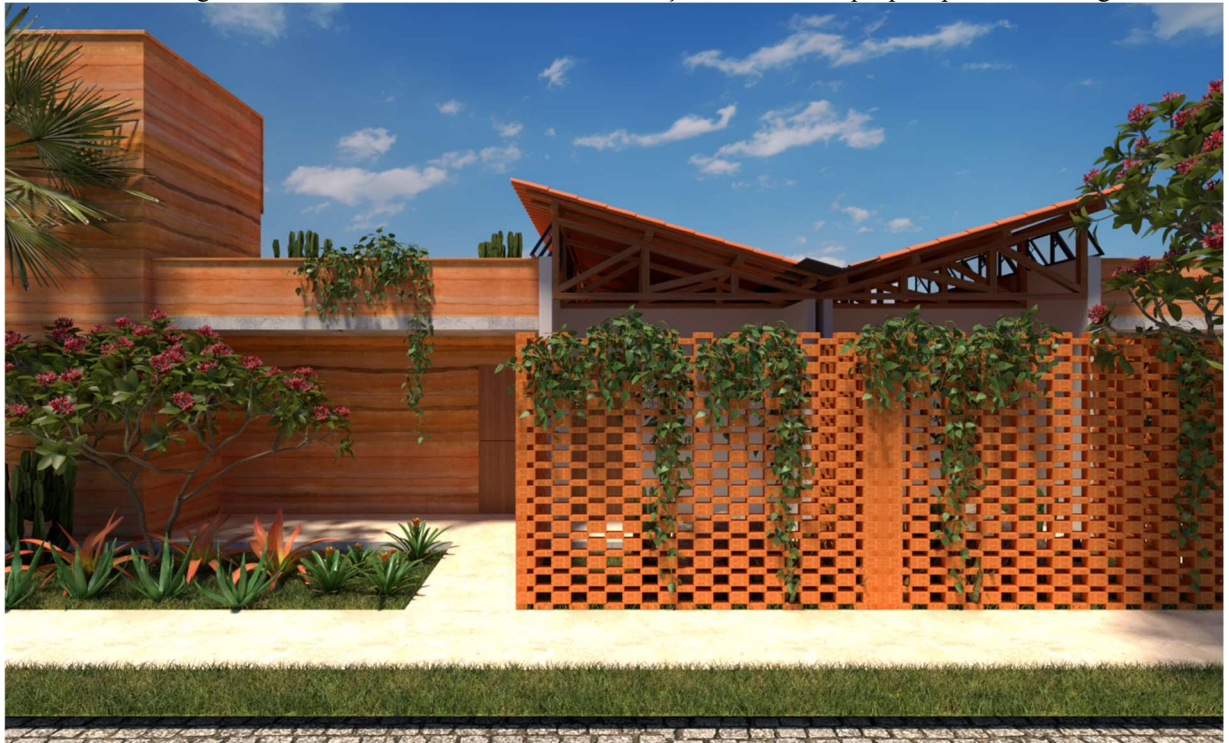
Figura 60: Fachada oeste do modelo de habitação 2, com destaque para painel de cobogós.
