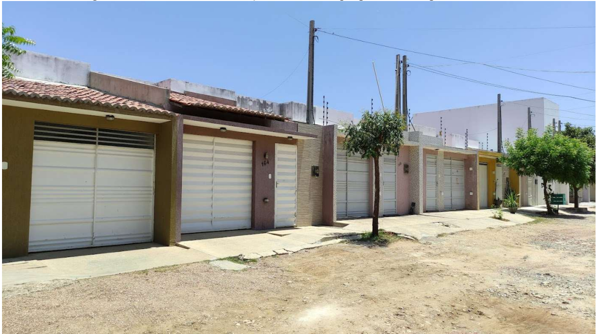
Figura 39: Fachadas das edificações, com destaque para falta de permeabilidade.
