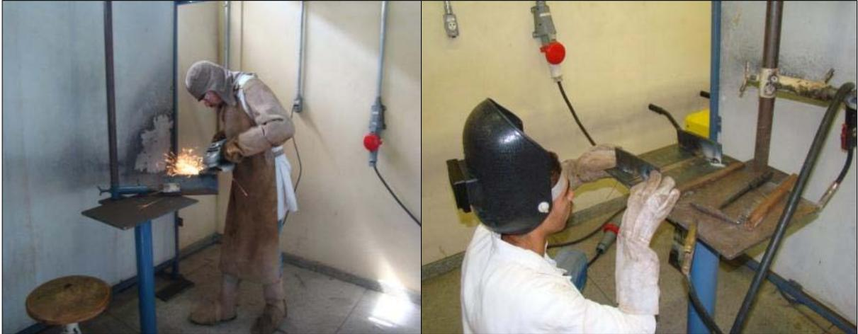
Figura 4.7 – Preparação do corpo de prova de soldagem.
