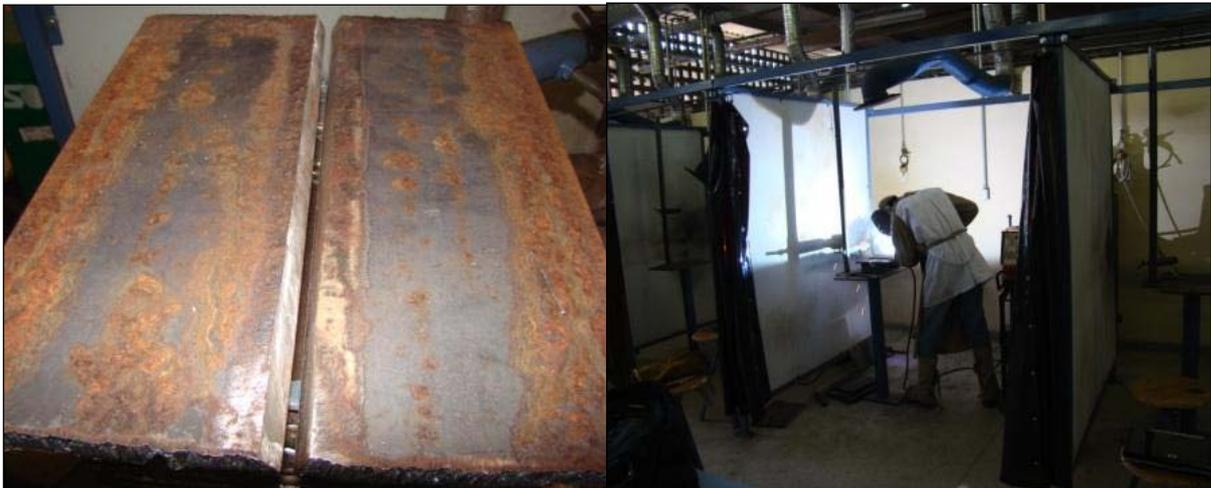
Figura 4.8 – (a) Corpo de prova pronto para a soldagem. (b) Soldagem sendo realizada.
