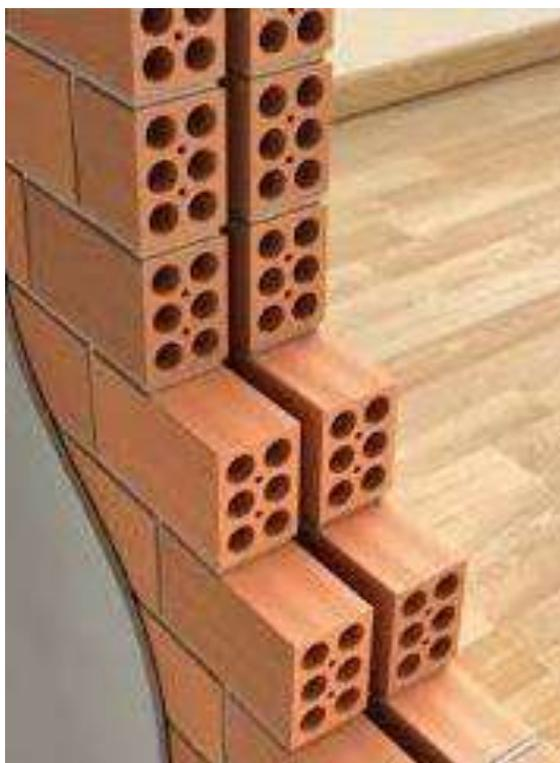
Figura 29: Parede dupla com câmara de ar. Fonte: Portal Construção Fácil.
