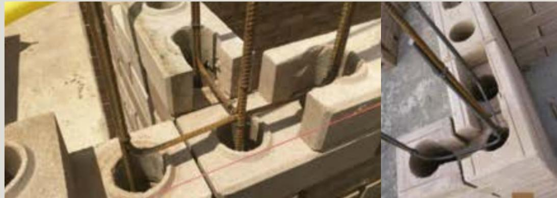
(F14) Inserção dos grampos de amarração em obra com tijolos ecológicos. Fonte: Manual de Boas Práticas da Execução de Alvenaria Modular de Solo-cimento - Universidade Estadual de Minas Gerais (UEMG)
