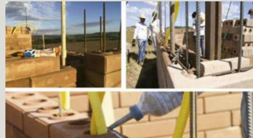
(F16) Processo de instalações elétricas e hidráulicas em obra com tijolos ecológicos. Fonte: Manual de Boas Práticas da Execução de Alvenaria Modular de Solo-cimento - Universidade Estadual de Minas Gerais (UEMG)
