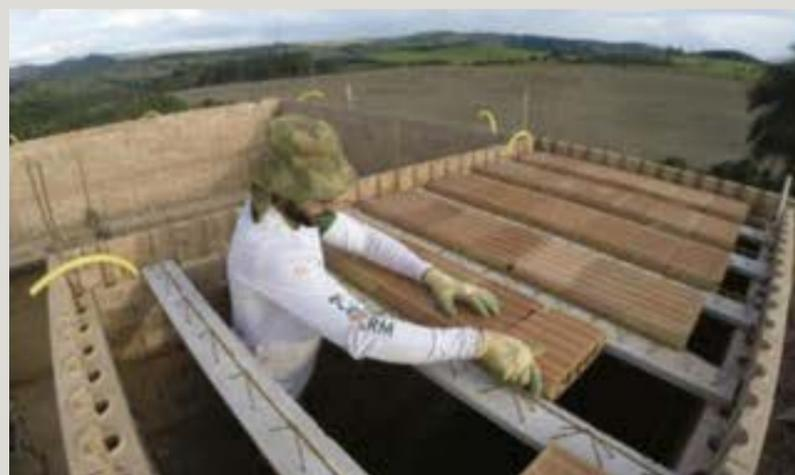
(F19) Processo de montagem da laje em obra com tijolos ecológicos.
