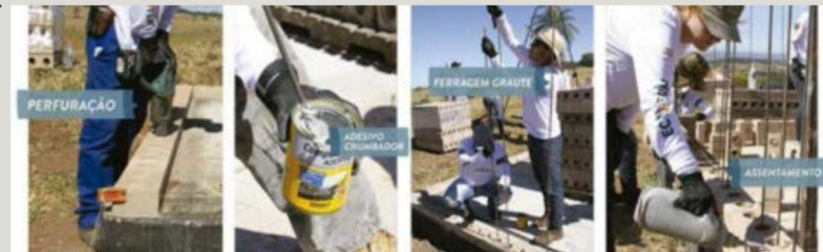
(F13) Passo a passo do processo de inserção dos grautes em obra com tijolos ecológicos. Fonte: Manual de Boas Práticas da Execução de Alvenaria Modular de Solo-cimento - Universidade Estadual de Minas Gerais (UEMG)
