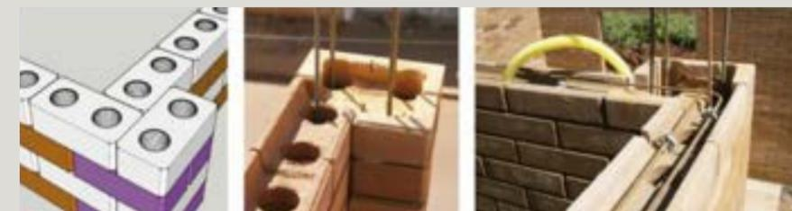
(F17) Demonstração do funcionamento das canaletas como reforço estrutural em obra com tijolos ecológicos. Fonte: Manual de Boas Práticas da Execução de Alvenaria Modular de Solo-cimento - Universidade Estadual de Minas Gerais (UEMG)
