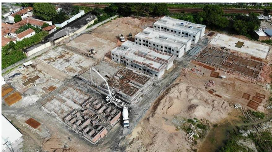
Figura 30 - Fase inicial das obras do Conjunto Habitacional Ruy Frazão. Pode-se observar o embasamento de alguns blocos, bem como blocos com dois pavimentos finalizados e a construção do pavimento térreo em um dos blocos.
