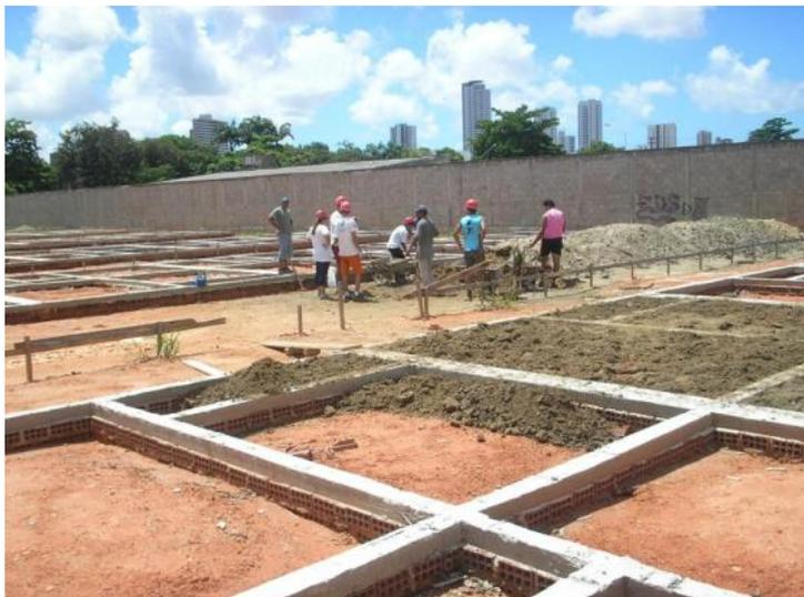
Figura 14: Construção das bases das moradias pelas famílias.
