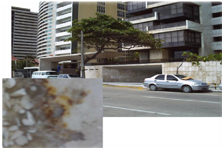
Figura 4.5 - Aspecto de fachada com revestimento de “Bege Bahia”, com 15 anos de exposição. Notar a segregação secundária (detalhe) resultante da mobilização e reprecipitação de Fe sob influência intempérica.
