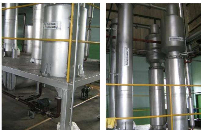
Figura 4.15 - Tanque pulmão da fase pesada, evaporador 1 e condensador 3.
