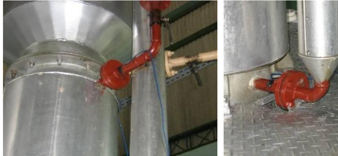
Figura 5.36 - Coleta de temperaturas de entrada e saída de óleo mineral no evaporador 2.
