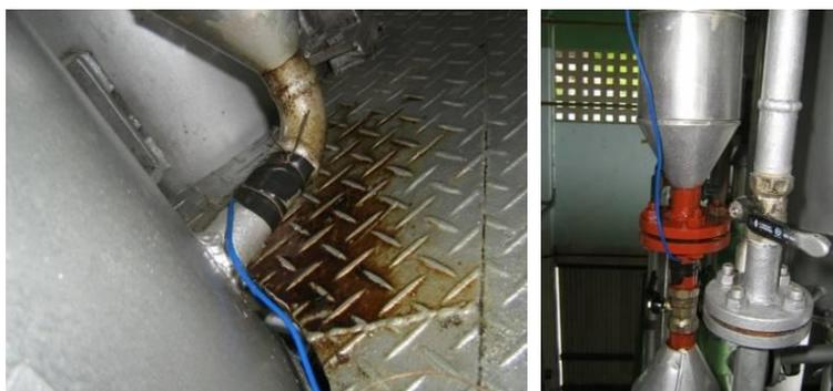
Figura 5.15 - Pontos de medições no processo de desumidificação do óleo neutralizado, medidas com termopares.
