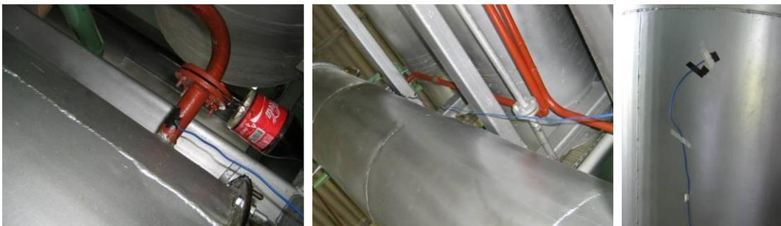
Figura 5.11 - Pontos de medição com termopares na neutralização do óleo bruto.
