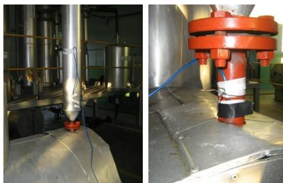
Figura 5.29 - Termopares colocados na torre de destilação para medir a entrada e saída do óleo mineral.
