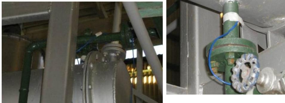
Figura 5.30 - Termopares colocados nos condensadores horizontais para medir as temperaturas de entrada e saída da água, e entrada do vapor de álcool.
