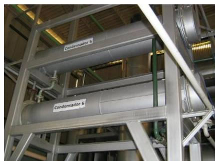
Figura 4.18 - Condensadores horizontais.
