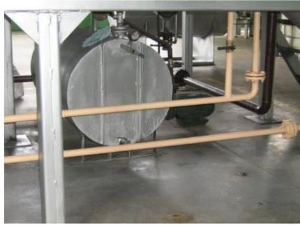
Figura 4.16 - Tanque do condensado.
