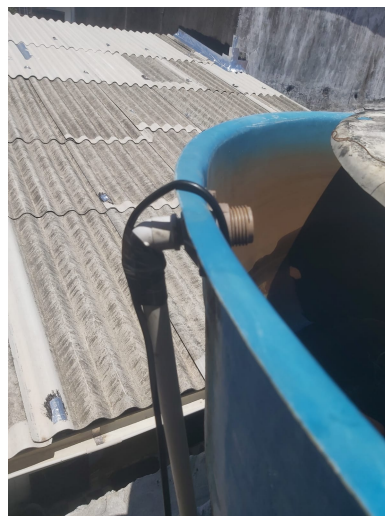
Figura 38: Fio da bóia dentro da caixa d'água.
