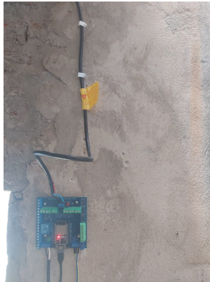
Figura 37: Instalação do fio da bóia na PCB.
