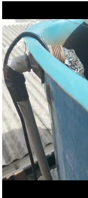
Figura 46: Enchimento da caixa d'água.
