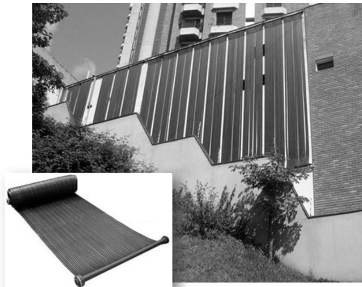
Figura 2.8: Coletores de placa plana sem cobertura fabricados em material polimérico instalados na lateral de um prédio
