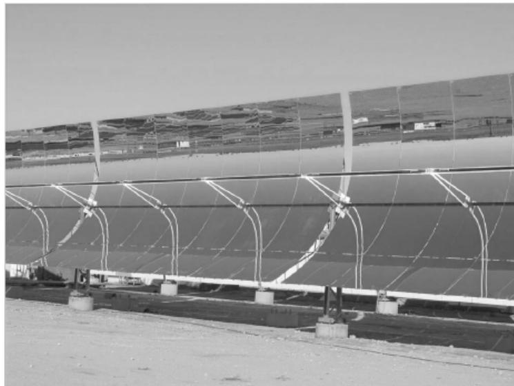
Figura 2.10: Coletor concentrador parabólico
