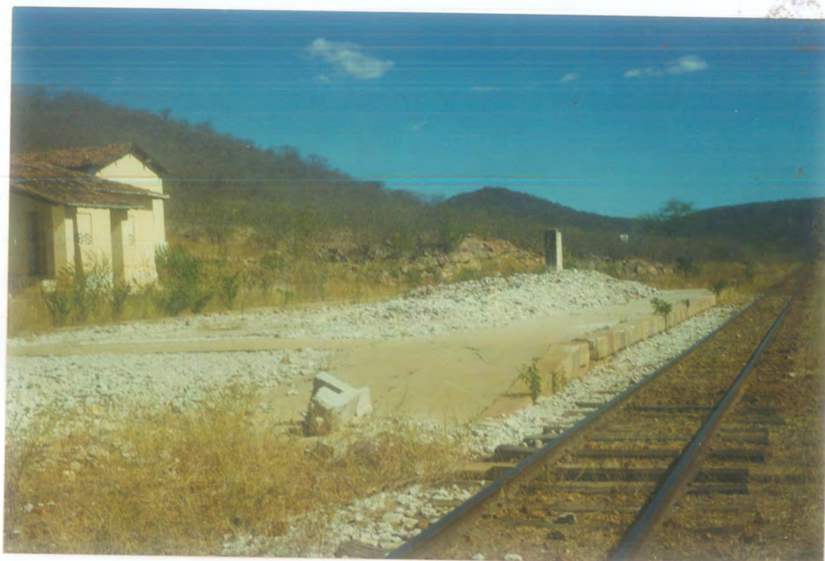
3. Ruínas do prédio onde funcionou a estação ferroviária de Oiticica.
