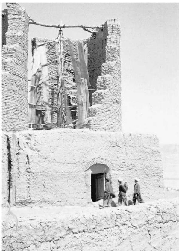
**Figura 59 - Aerogerador de eixo vertical de Sistan Basin na fronteira entre Irã e Afeganistão. Fonte: (MÜLLER, JENTSCH e STODDART, 2008).**
