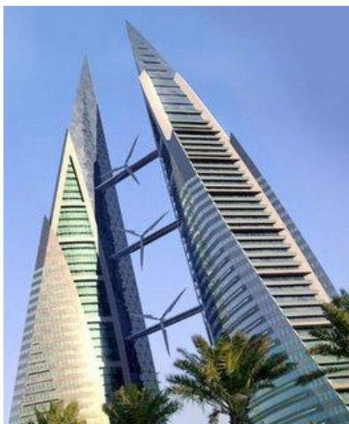
**Figura 21 - Bahain World Trade Center em Manama, Barém, construído em 2008 e possui três aerogeradores encapsulados pelo edifício. Fonte: (BAHRAIN WORLD TRADE CENTER, 2010).**
