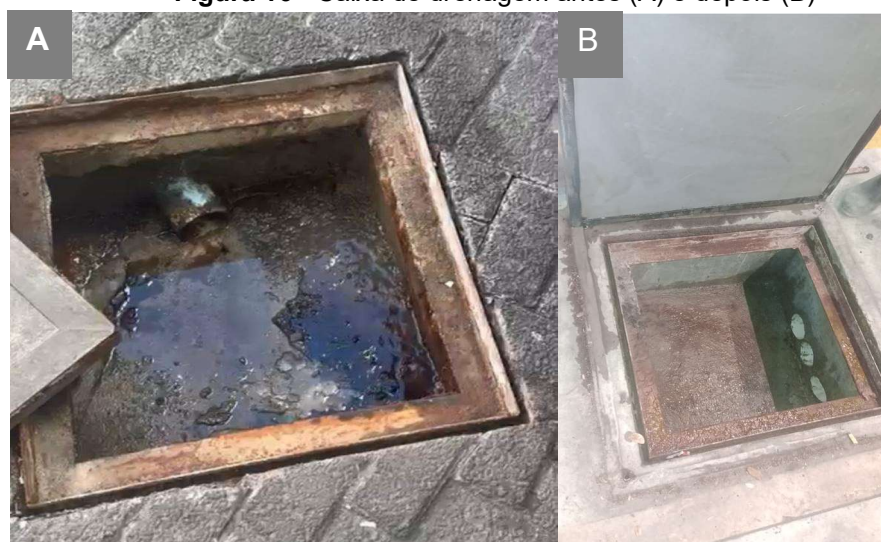
Figura 16 - Caixa de drenagem antes (A) e depois (B)
