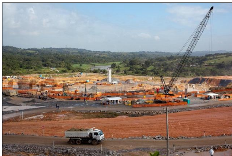
Fig. 3.2 – Vista do canteiro de obras da Arena Pernambuco.
