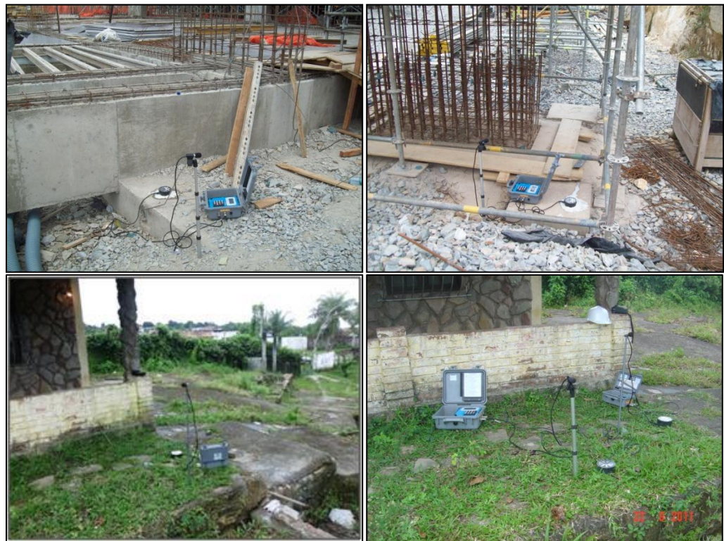
Fig. 3.6 – Imagens dos monitoramentos sismográficos executados nas estruturas da Arena Pernambuco e nas estruturas residenciais nas proximidades.
