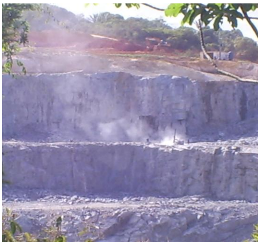
(a) Operação unitária de perfuração com perfuratriz pneumática.
