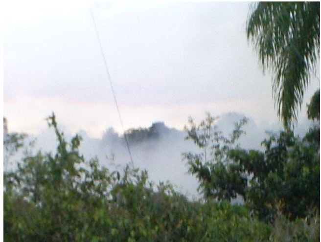
(b) Efeito do desmonte secundário.
