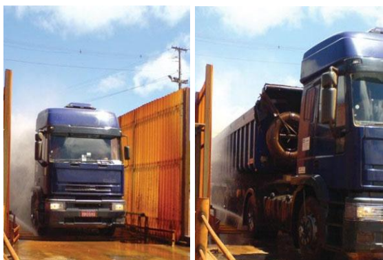
(f) Lavagem dos veículos com aspersores.
