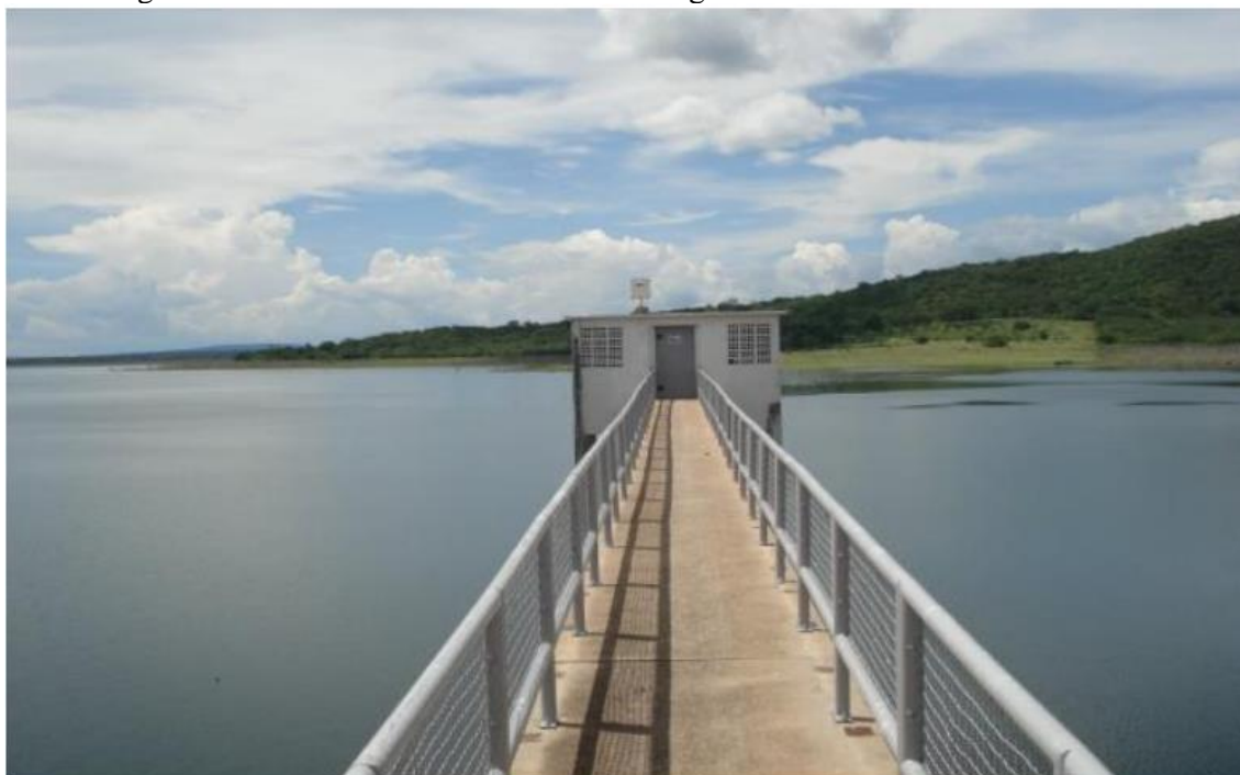
Figura 10 - Torre de comando da tomada d'água do reservatório de Entremontes
