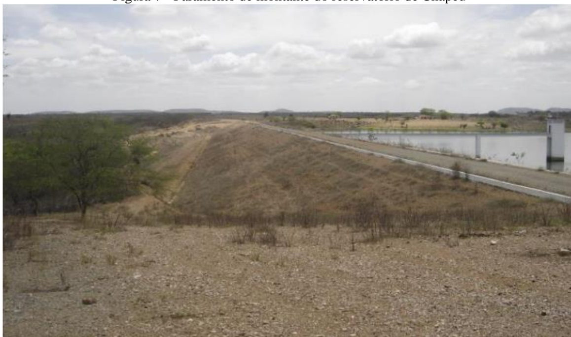
Figura 7 - Paramento de montante do reservatório de Chapéu
