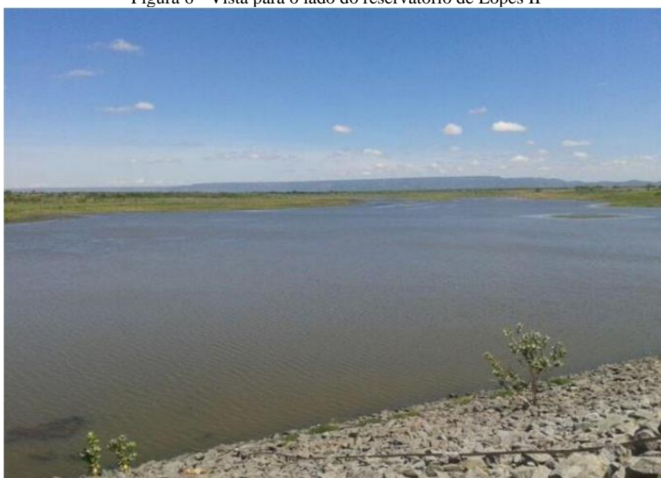
Figura 6 - Vista para o lado do reservatório de Lopes II
