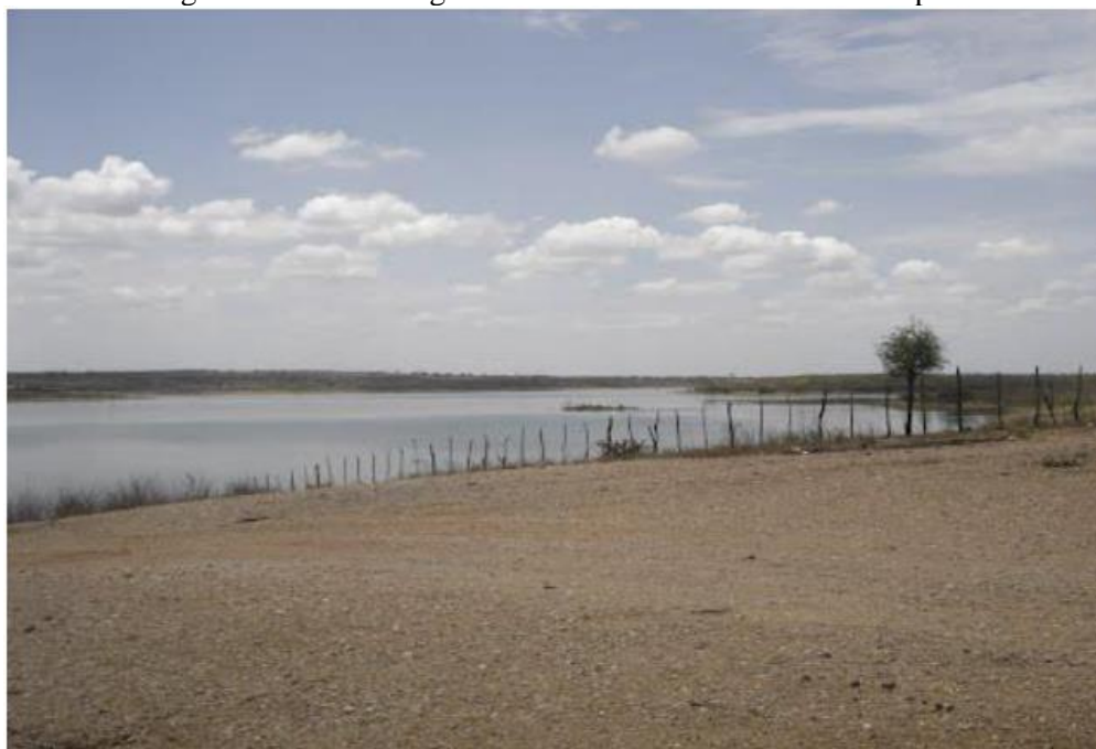
Figura 8 - Vista do lago a montante do reservatório de Chapéu
