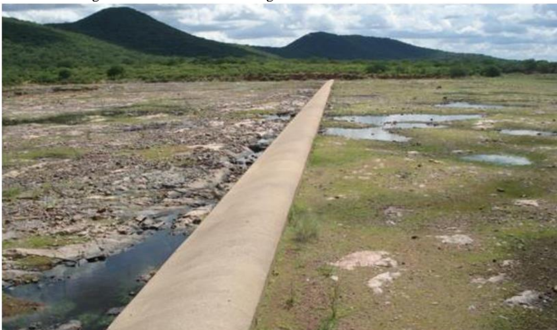
Figura 9 - Vertedouro da Barragem do reservatório de Entremontes
