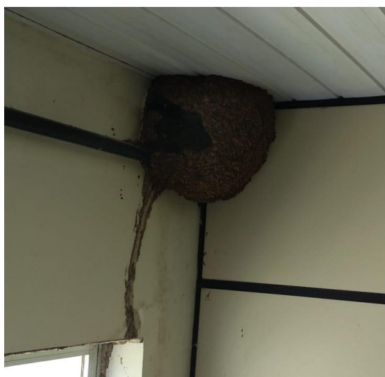
Figura 11: Indício de presença de cupins.
