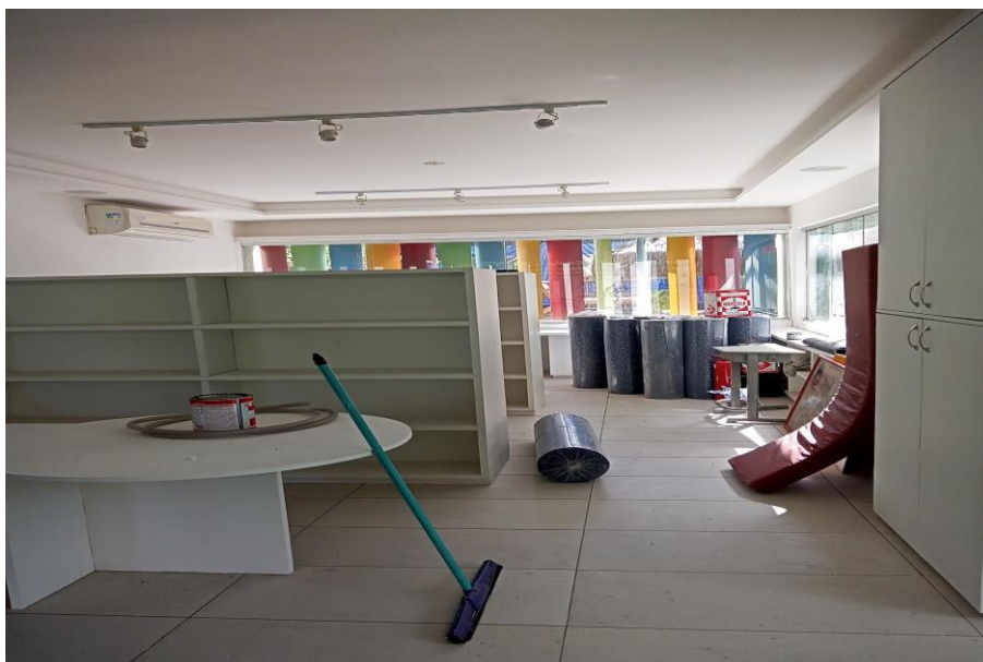
Figura 3 - Reforma da Sala Google
