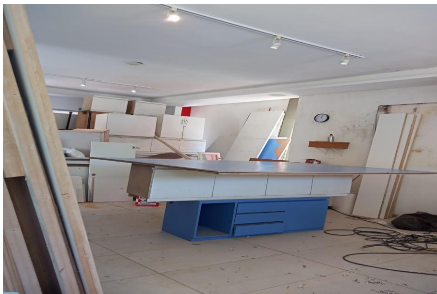
Figura 4 - Reforma da Sala Google
