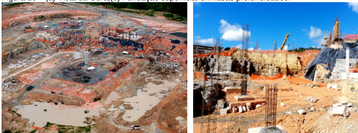
Figura 26 – (a) Vista da Obra;(b) Fundação superficial em rasas profundidades.
