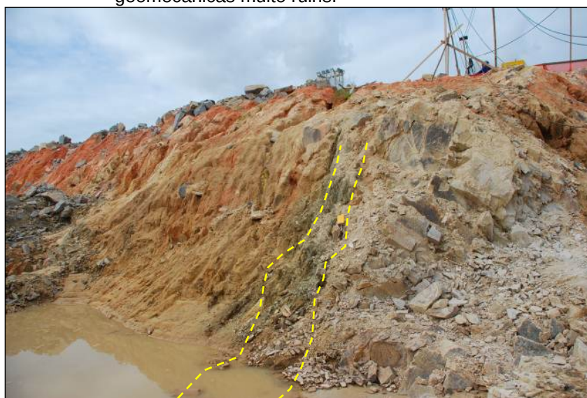
Figura 37 – Situação do talude de corte do Setor Oeste apresentando falha geológica observada com rocha muito deformada e com propriedades geomecânicas muito ruins.
