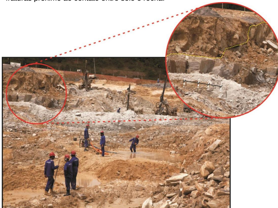
Figura 32 – Situação do talude de corte do Setor Sul para análise dos parâmetros de discontinuidades. Eventual presença de matacões ou zonas de rocha alterada com muitas fraturas próximo ao contato entre solo e rocha.
