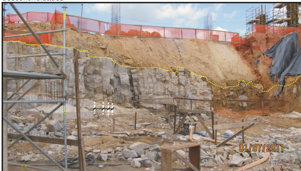
Figura 30 – Situação do talude de corte do Setor Sudeste para análise dos parâmetros de descontinuidades
