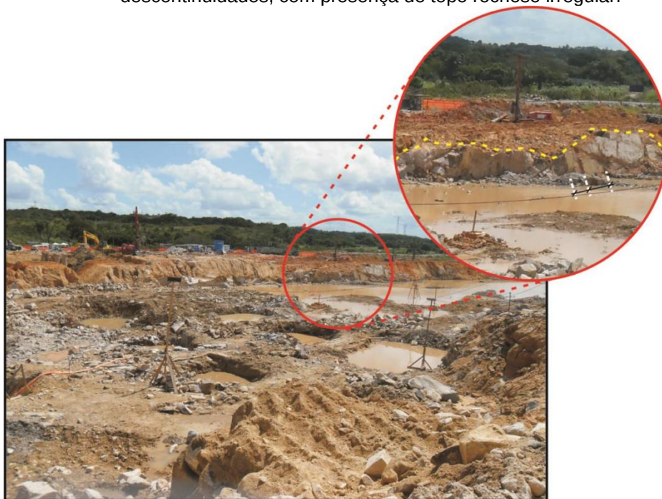
Figura 36 – Situação do talude de corte do Setor Oeste para análise dos parâmetros de descontinuidades, com presença de topo rochoso irregular.
