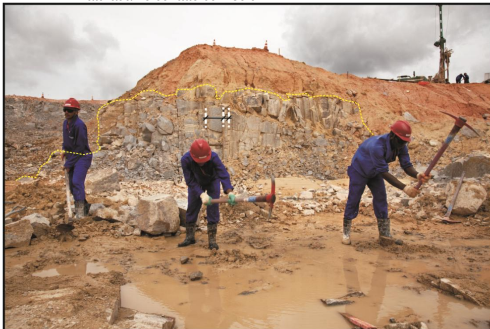
Figura 34 – Situação do talude de corte do Setor Sudoeste para análise dos parâmetros de descontinuidades, com presença de topo rochoso irregular e presença de rocha fraturada no contato com solo.
