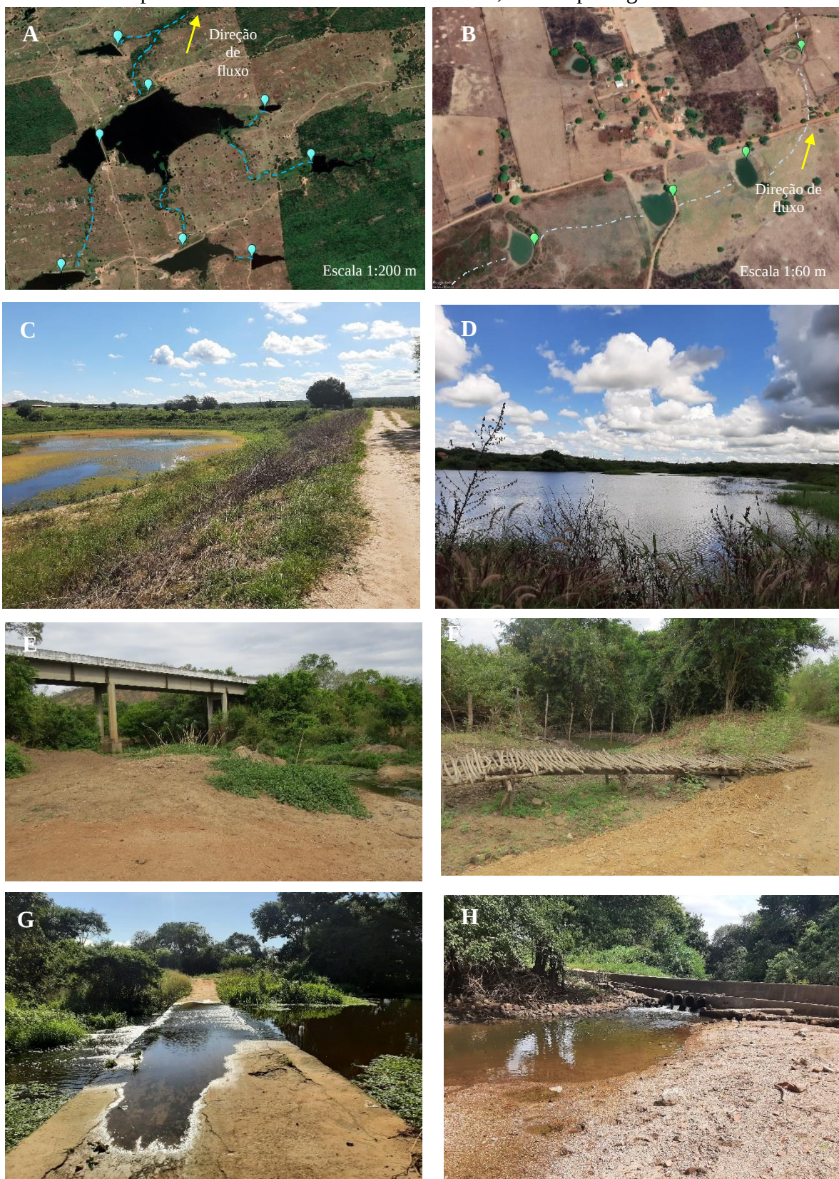
Figura 50- Elementos desconectantes que não foram considerados na análise. A- Barragens em sequência, B- barreiros, C e D- barragens pequenas, E- ponte, F- estrutura para passagem de pedestres e estrada transversal ao canal, G e H- passagem molhada.
