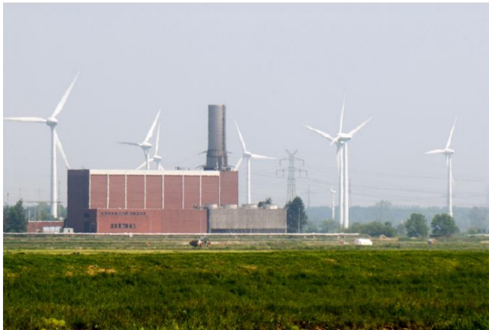
Figura 10 – planta CAES instalada em Huntorf
