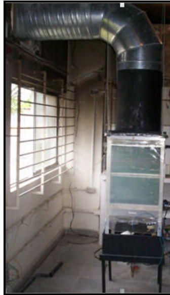
Figura 4.1 – Vista geral da torre.
