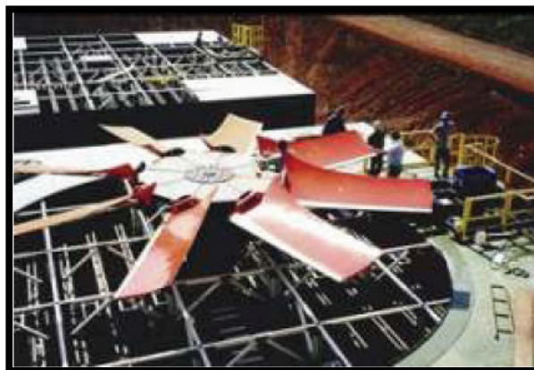
Figura 1.13 – Ventilador axial de grande porte (ALPINA, 2006).
