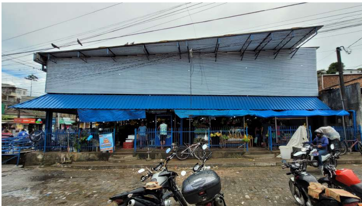
F51 | Fachada leste da FNND, após intervenção.
