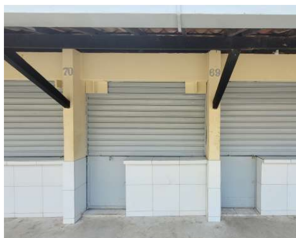
F58 | Vista do corredor de acesso às lojas da MPND, após intervenção.
