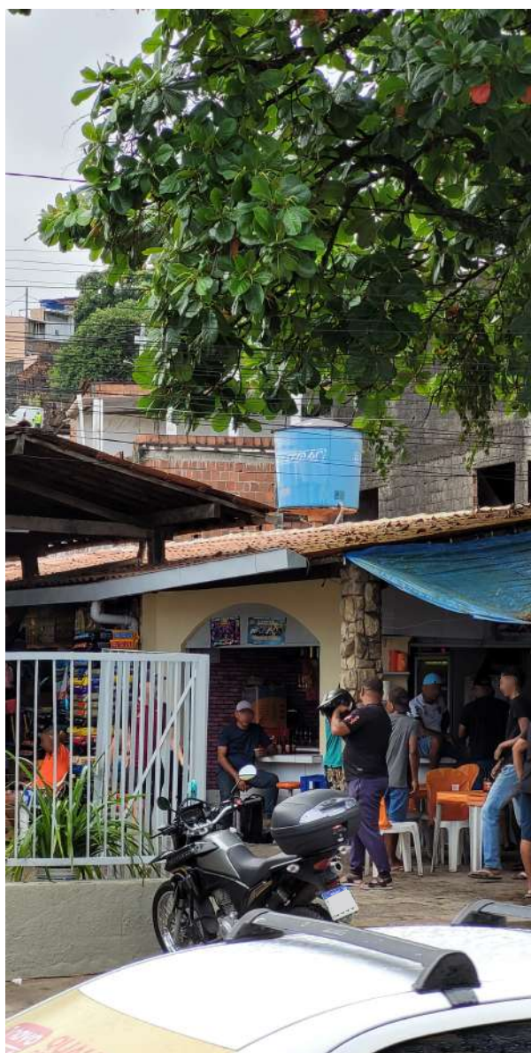
F61 | Aproximação de bar do MPND, após a intervenção.
