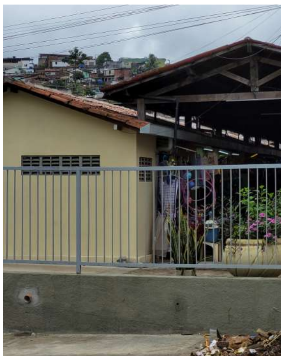
F59 | Vista lateral dos blocos de lojas do MPND, após a intervenção.
