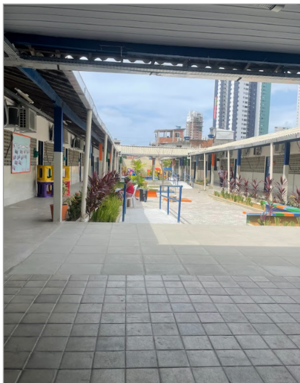
Figura 46 - Foto Pátio interno da escola e circulação aberta e coberta.
