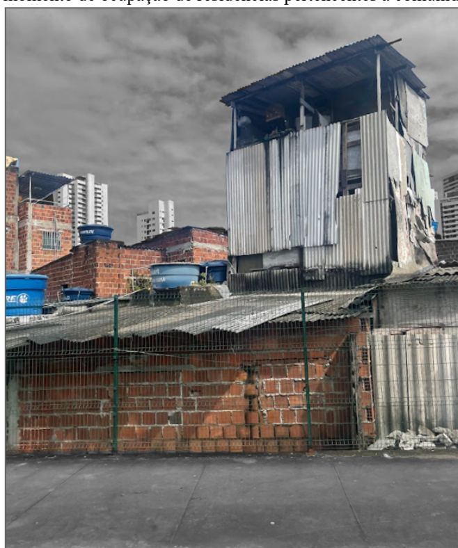
Figura 12 - Quarto momento de ocupação de residências pertencentes à comunidade Ilha do Destino.
