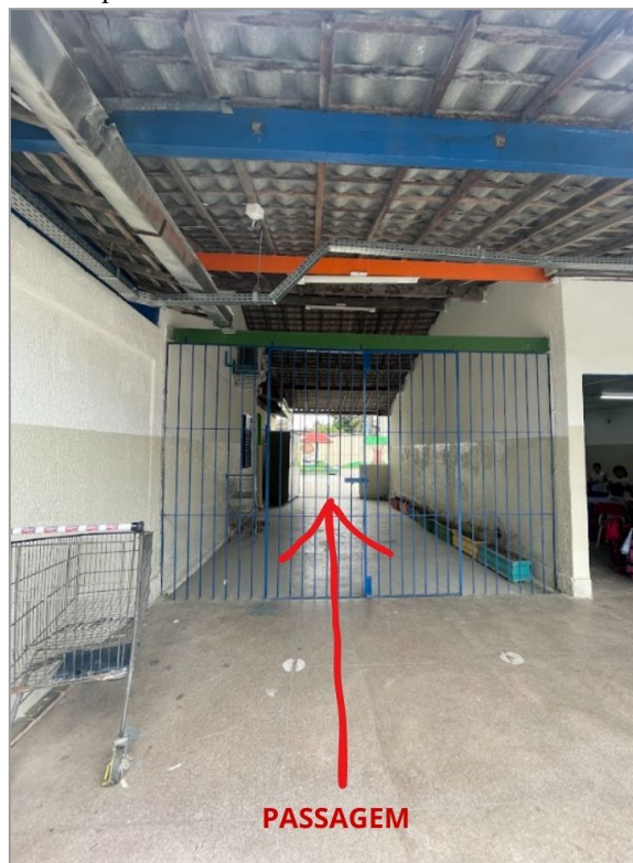
Figura 48 - Foto passagem interna para acesso ao pátio em frente ao bloco de vestiários.
