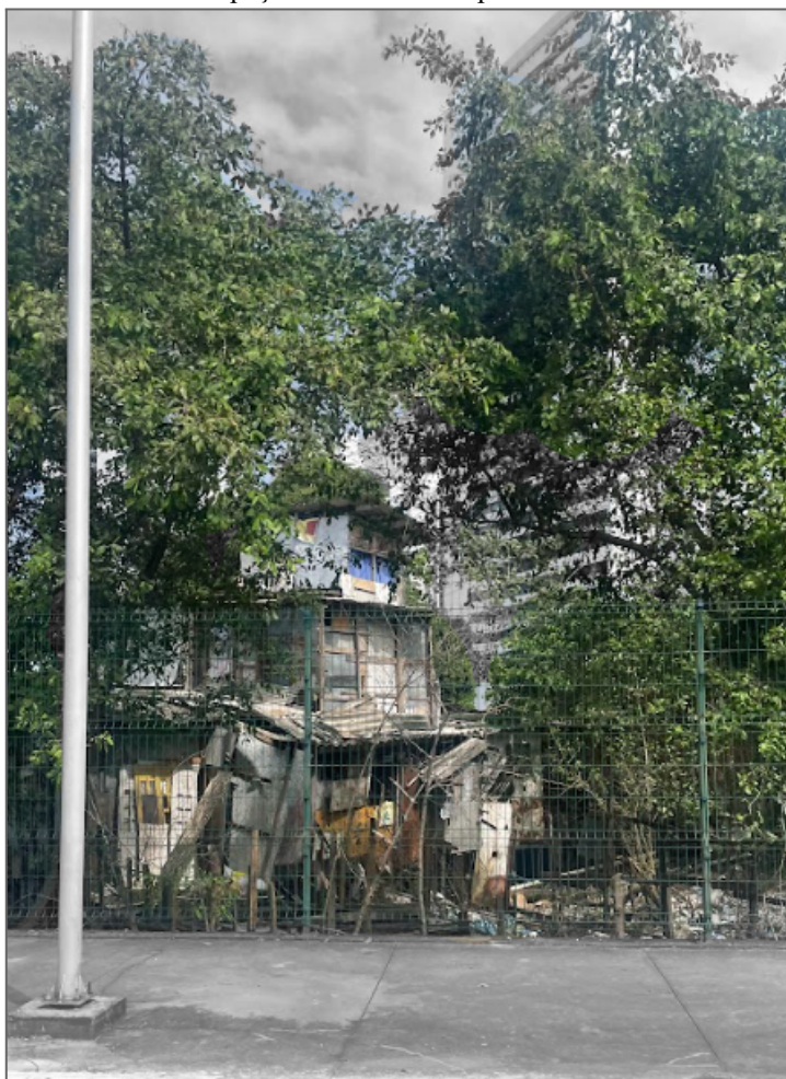
Figura 13 - Quarto momento de ocupação de residências pertencentes à comunidade Ilha do Destino.
