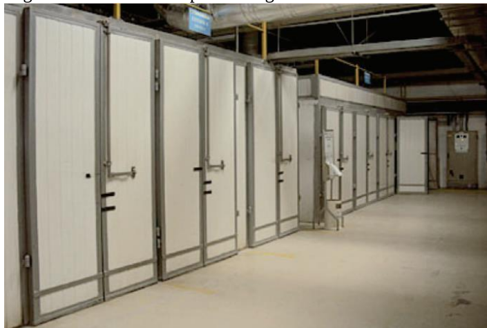
Figura 4 – Estufas na etapa de secagem
