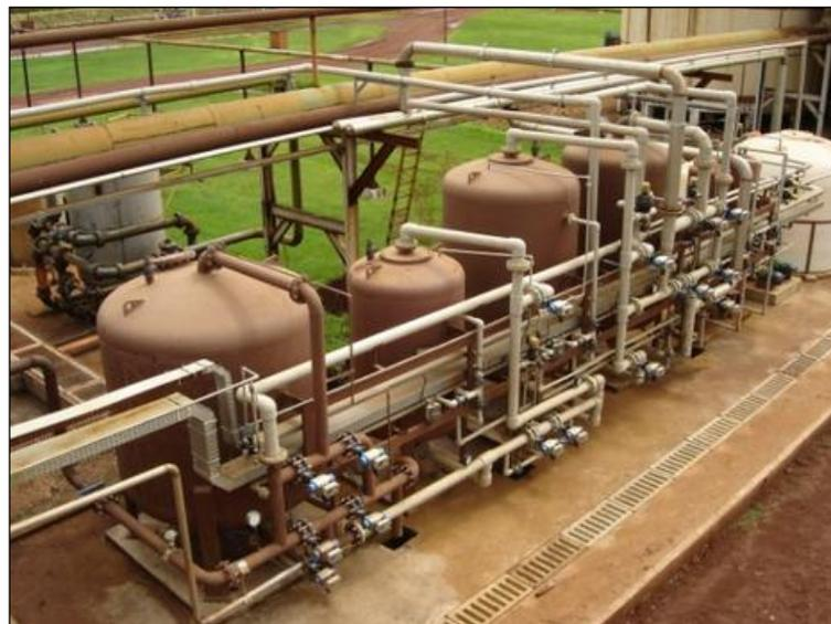
Figura 4-23. Sistema de tratamento de água
