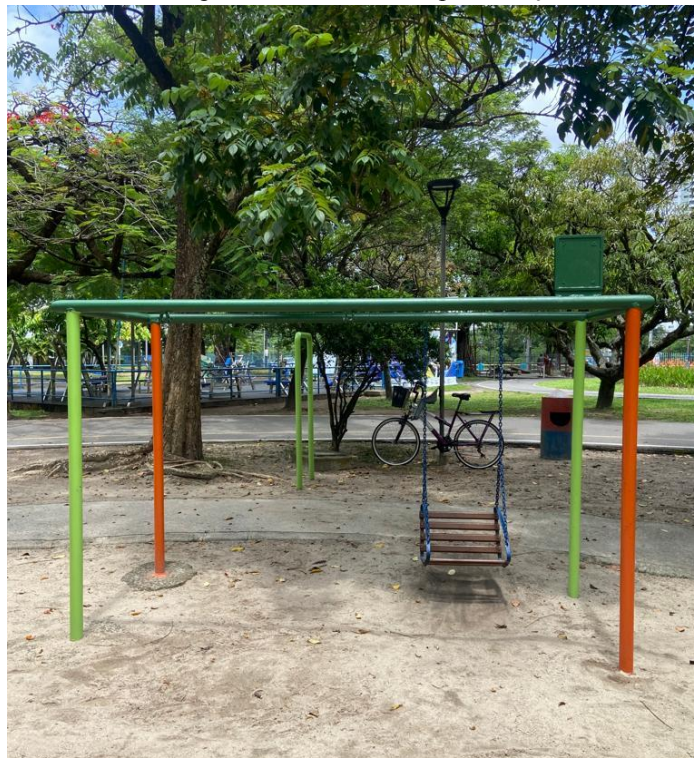
Figura 62: Área de brinquedos adaptados sem sinalização e sem o balanço adaptado, está apenas com a estrutura para fixação.
