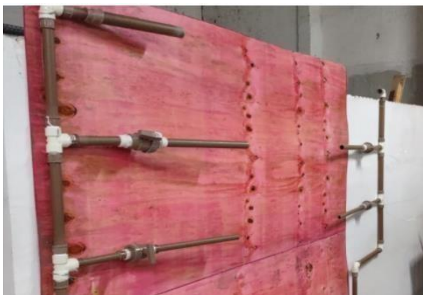
Figura 18 – Montagem da estrutura parede
