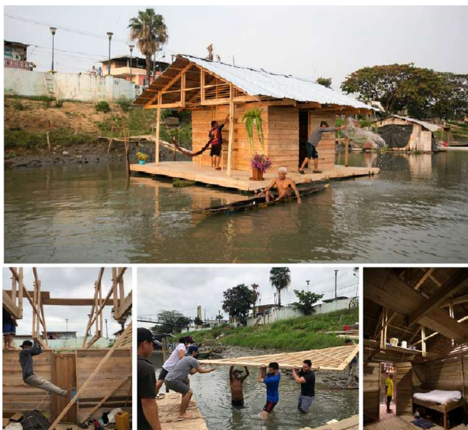
Figura 38: Construção de habitação flutuante para um reparador de canoas e pescador, por meio de financiamento coletivo e mutirão . Babahoyo, Equador, 2020
