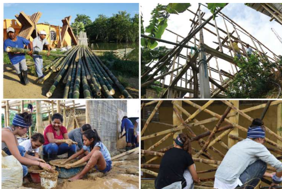
Figura 42: Etapas de montagem da estrutura, revestimento e fechamento com argila e bambu
