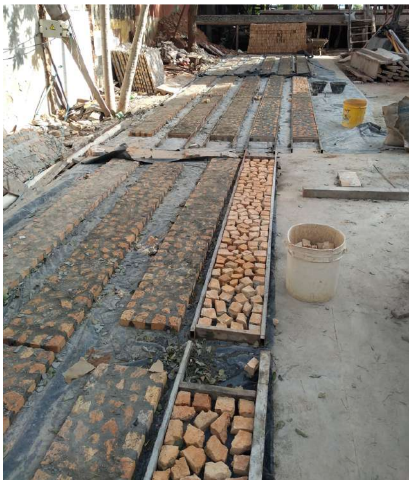
Figura 33: Pré-fabricação de painéis de tijolos partidos e argamassa no canteiro de obras. Assunção, Paraguai, 2019
