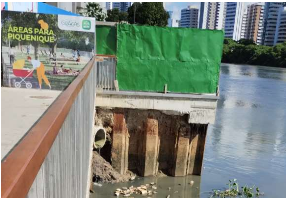
Figura 23 - Registro fotográfico do trecho em construção Graças
