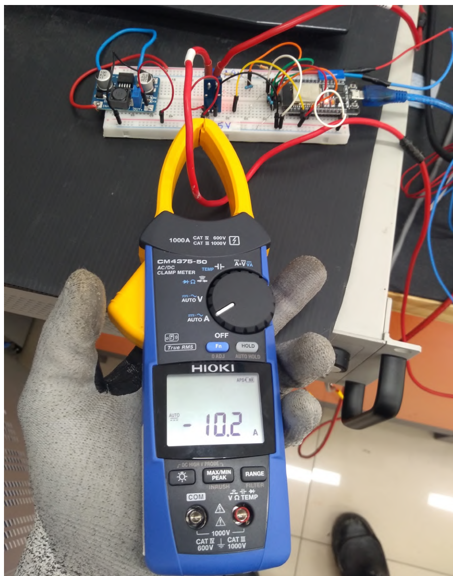
Figura 3.16: Registro da corrente elétrica no alicate amperímetro (Fonte: o autor).
