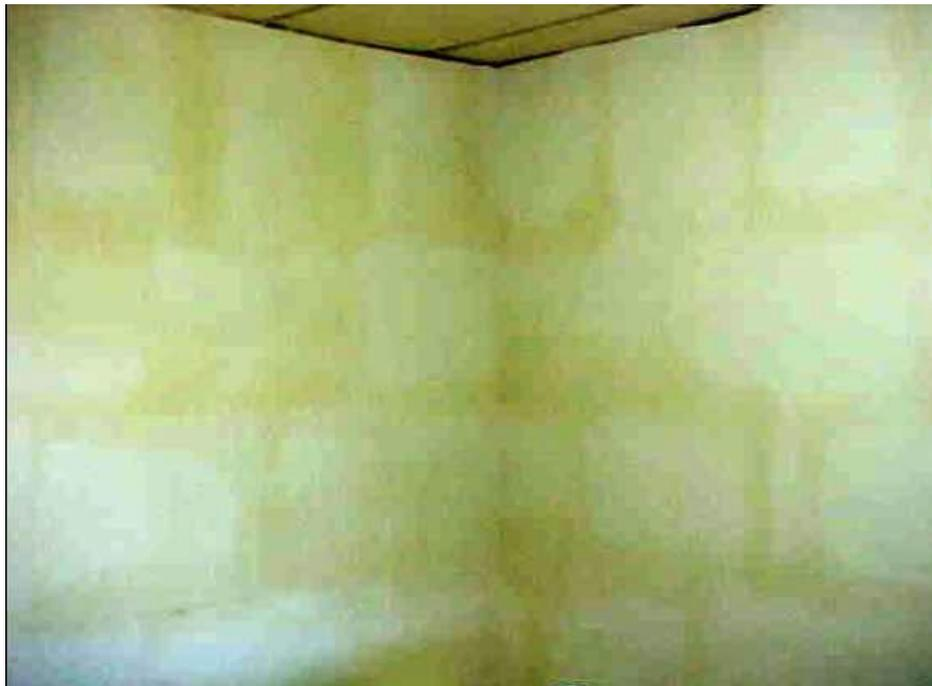
Figura 4.2 – Foto do amarelamento em paredes de divisórias de pré-moldados de gesso
