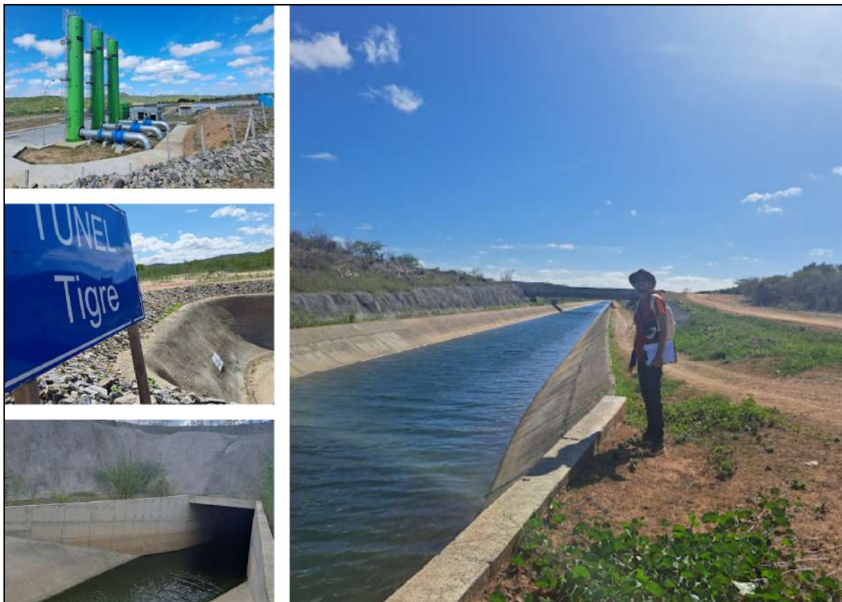
Figura 2. Estruturas do Projeto de Integração do Rio São Francisco evidenciadas em trabalho de campo.
