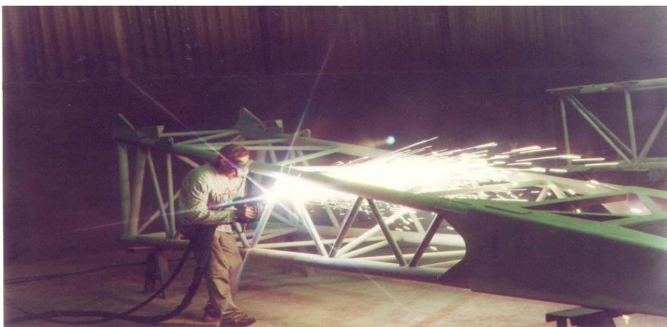
Figura 2.3.1 – Processo de aspersão térmica aplicado para proteção contra corrosão.
