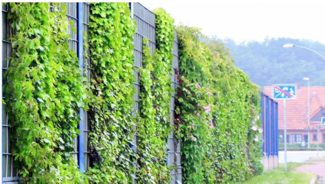
Figura 47 - Barreira acústica recoberta em vegetação
