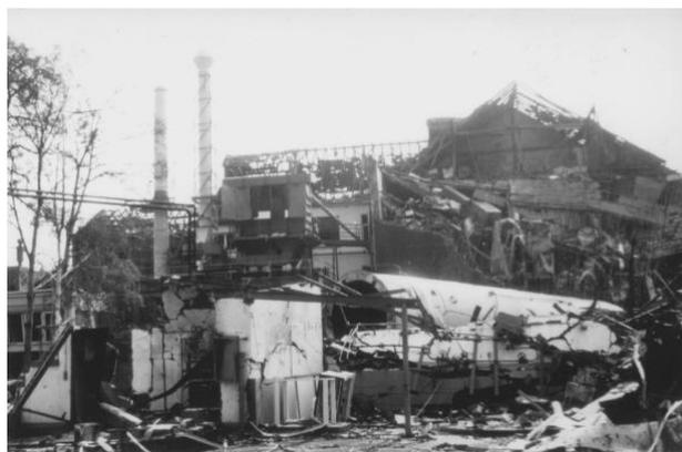
**Figura 2.1** Acidente devido a ruptura e explosão de um tanque de armazenamento de hidrogênio em uma fábrica
